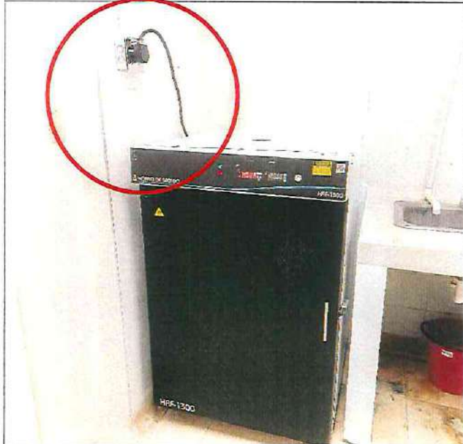
1,11 Suministro e instalación de Cable de cobre encauchetado 3 x 10 AWG
