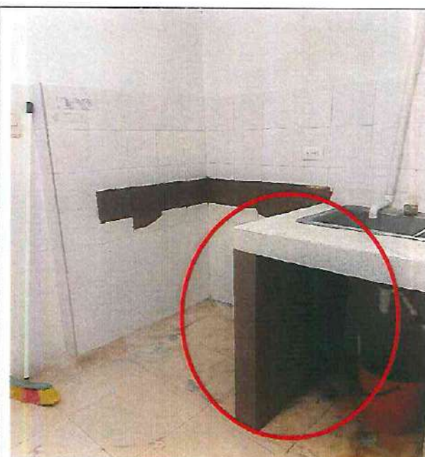
1,14 279. Pañete liso muros 1:4
