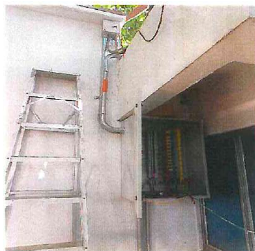
1,05. Acometida aérea en cable de cobre aislado 4x8+1x10T AWG THHN/THWN-2 600 V 90°C. Suministro e instalación.
