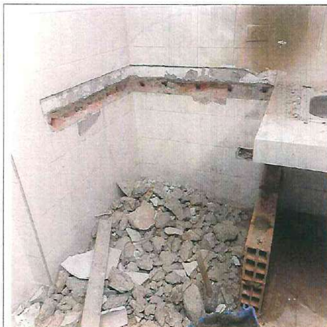
1,12 Demolición manual de mesón en concreto A=0.60
