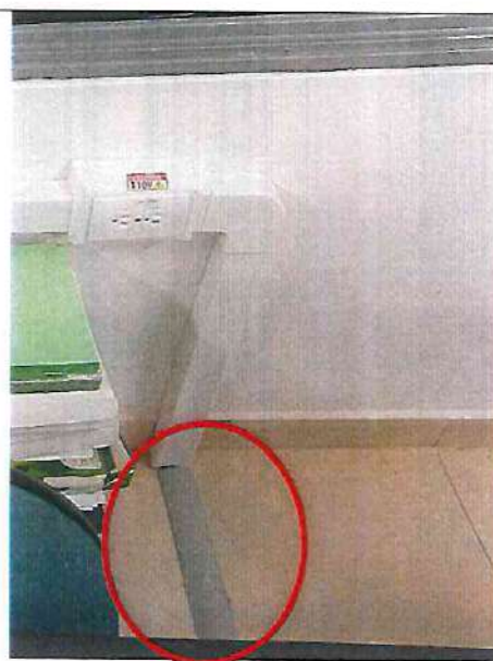
1,08 Suministro e instalación de canaleta plástica para piso con división, Incluye accesorios de fijación.
