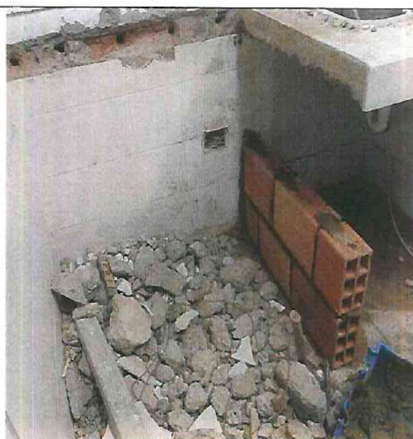
1,12 Demolición manual de mesón en concreto A=0.60
