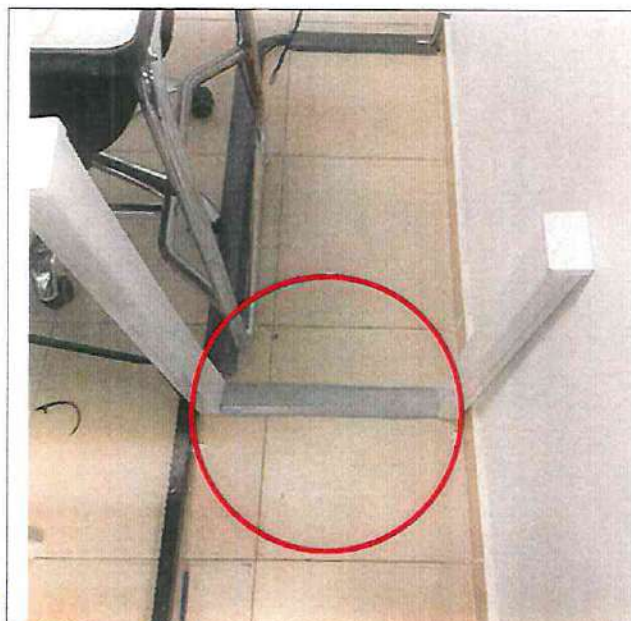
1,08 Suministro e instalación de canaleta plástica para piso con división, Incluye accesorios de fijación.
