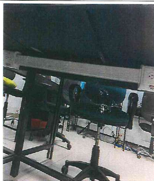
1,09 Suministro e instalación de canaleta plástica para muro con división, Incluye accesorios de fijación.
