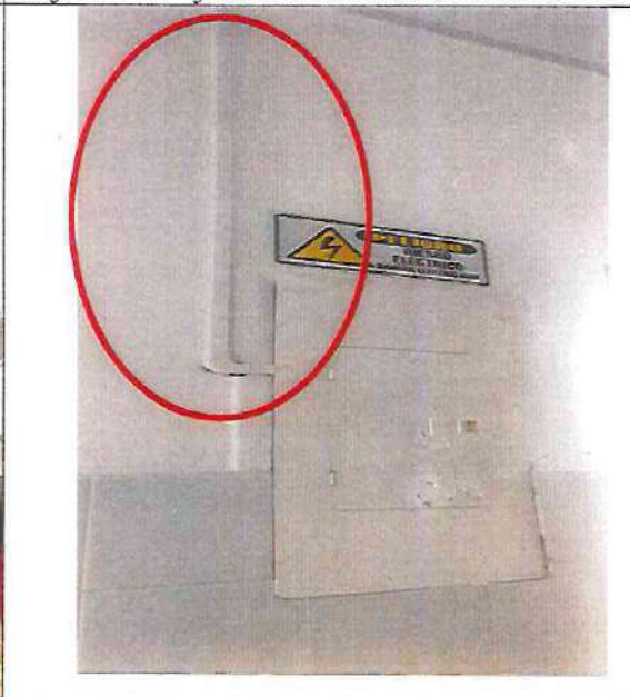
1,11 Suministro e instalación de Cable de cobre encauchetado 3 x 10 AWG
