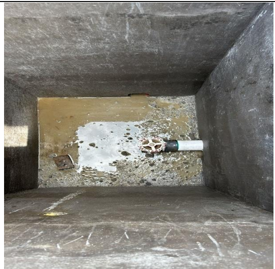
Foto 28 Instalación De válvulas de desagüe de tanques PTAP
