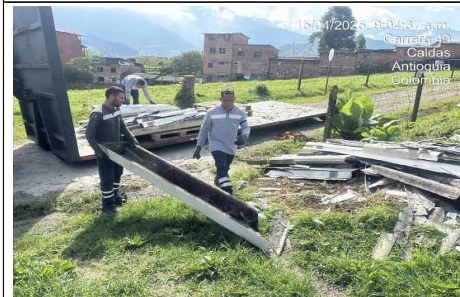
Foto 35 Disposición Final de Disposición residuos de asbesto cemento
