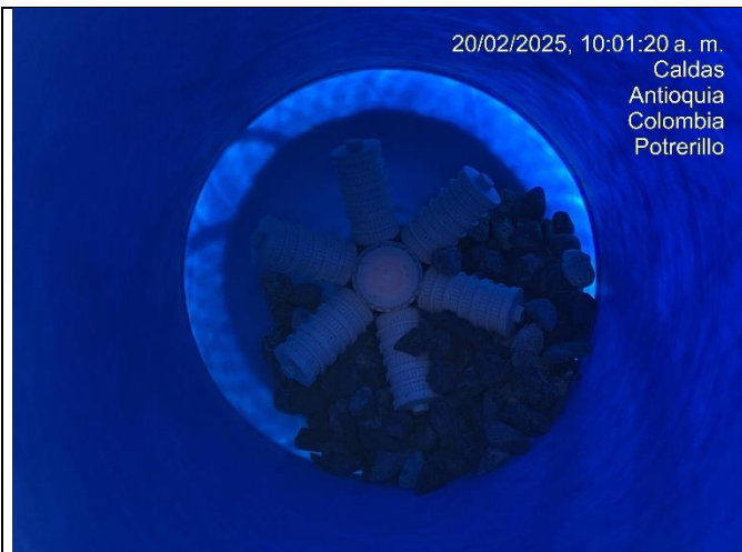
Foto 21 Llenado de material filtrante PTARnD Y PTARD
