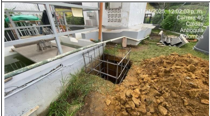
Foto 13 Construcción de cajas de desagüe de PATP
