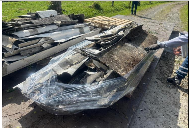
Foto 34 Disposición Final de Disposición residuos de asbesto cemento
