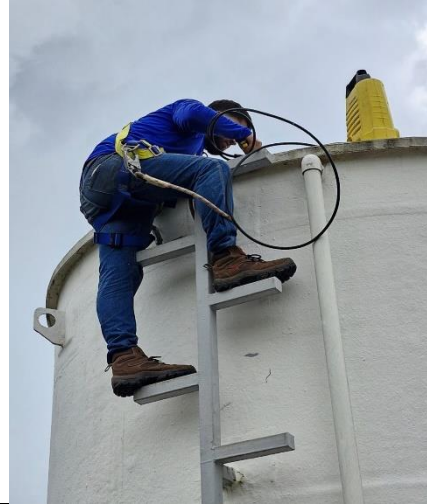
Foto 26 Limpieza de tanque de almacenamiento de 30 m3 existente PTAP
