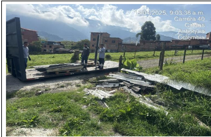
Foto 33 Disposición Final de Disposición residuos de asbesto cemento
