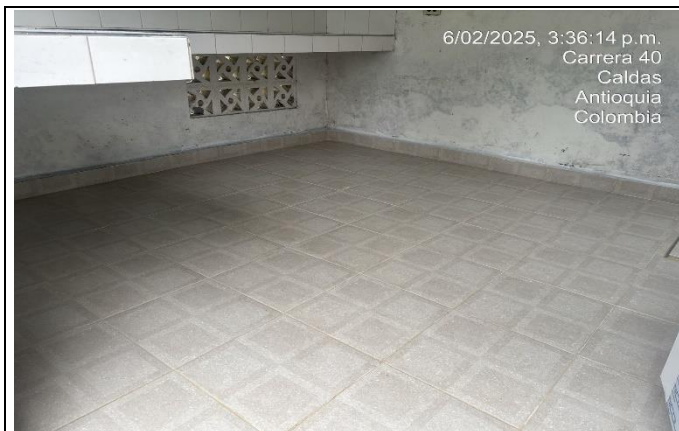
Foto 11 Instalación de cerámica en piso zona de laboratorio PTAP
