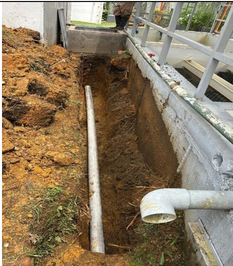
Foto 27 Instalación de tubería de desagüe de tanques PTAP
