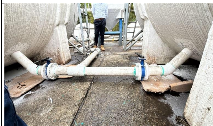
Foto 15 Conexión de tanques de proceso e instalación de válvulas PTARD
