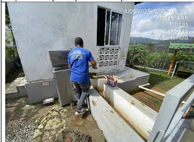
Foto 31 Reparación de detalles PTAP
