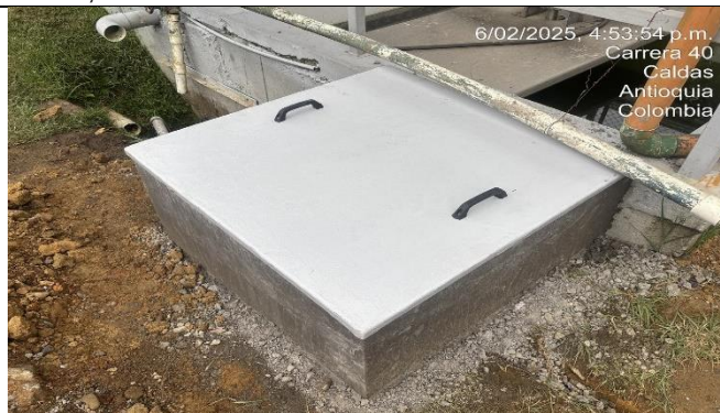
Foto 14 Construcción de cajas de desagüe de PATP
