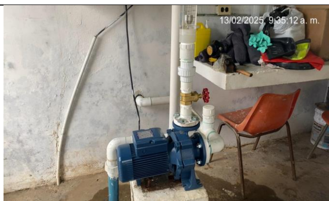
Foto 16 Instalación de moto bomba a filtros PTAP
