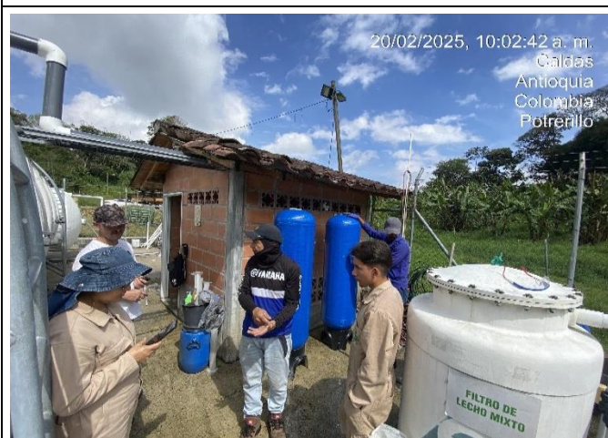
Foto 23 Capacitación manejo de equipos PTARD
