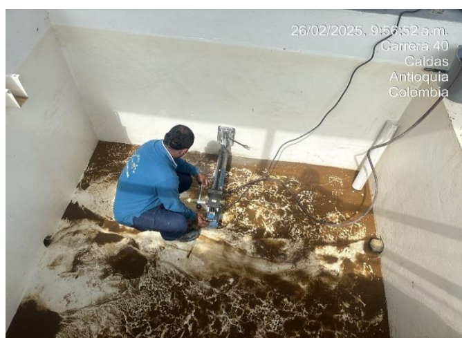
Foto 25 Perforación de tanques para desagües PTAP
