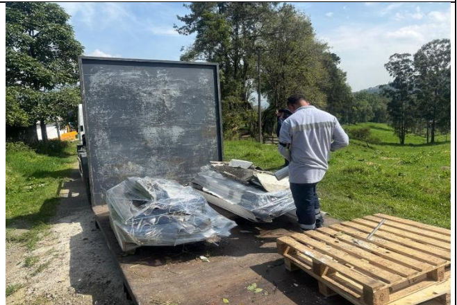
Foto 36 Disposición Final de Disposición residuos de asbesto cemento
