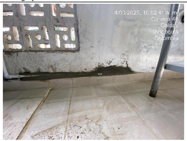
Foto 32 Reparación de detalles PTAP
