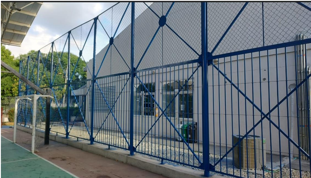
Malla contra impacto instalada en la zona establecida.
