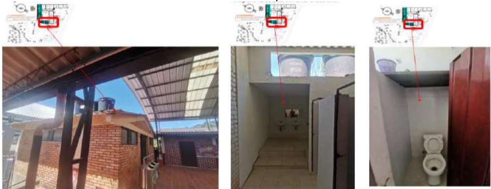
Baterías sanitarias a reconstruir Fuente: Propia
