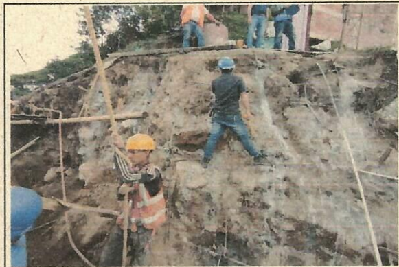
FOTO No 2 INYECCION ANCLAJES EN LAS VALLAS
