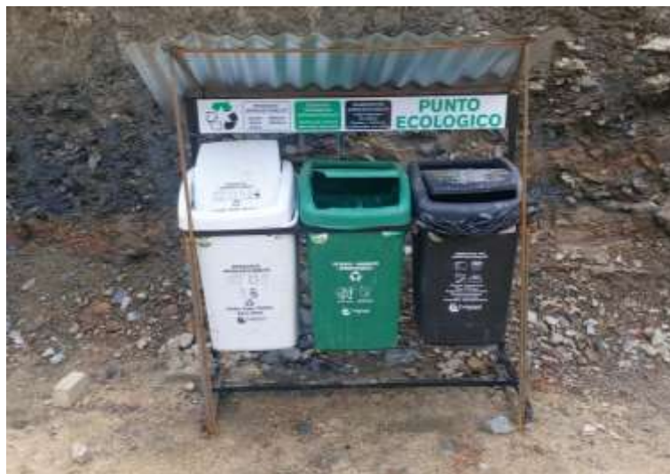
Fotografía No.2 Puntos ecológicos en obra.
