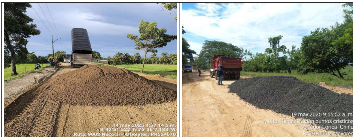
Fotos 5 y 6. Instalación de base y asfalto en frentes de obra
