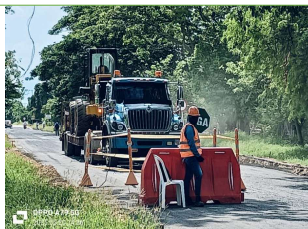
Señalización con auxiliar de tráfico, maletines balizas, en conformación de subrasante.
