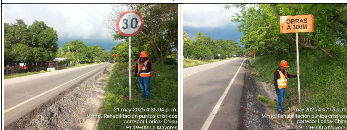
Fotos 9-10. Señalización, tramo Lorica-Chinú
