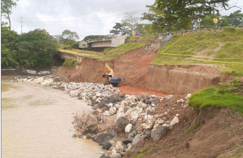
Foto 6. Trabajos sobre el talud puente mulatos.
