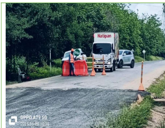
Señalización con auxiliar de tráfico, PR 19+300 en la compactación para conformación de subrasante
