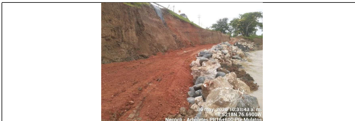
Ilustración 3 Materiales de construcción provisionados en los frentes de obra Fuente. Registro fotográfico del Consorcio Intering
