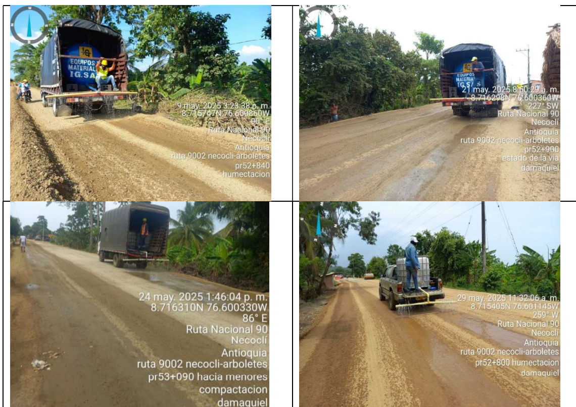
Ilustración 9 Humectación tramos viales intervenidos Fuente. Registro fotográfico Consorcio Interling
