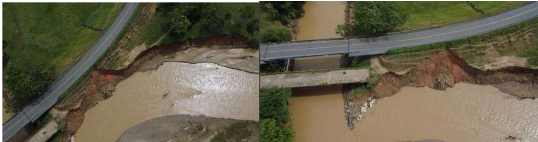
Fotos 1-2. Situación actual de PR 17+550
