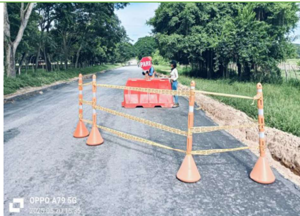
Señalización con auxiliar de tráfico, maletines balizas, en conformación de subrasante
