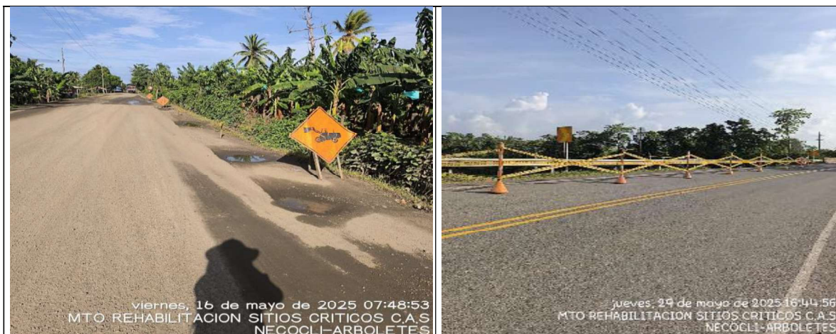
Fotos 7-8. Señalización, tramo Necoclí-Arboletes
