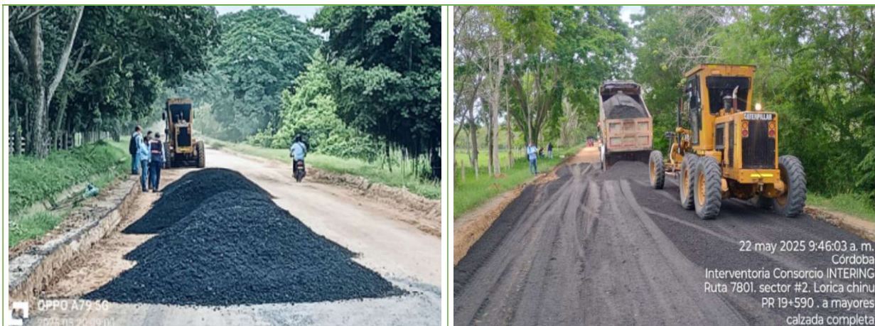
Ingreso de materiales de base en volquetas y mulas descargadas en la obra
