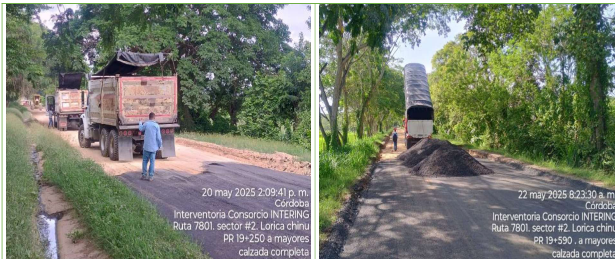
Ingreso de materiales en volquetas debidamente carpadas
