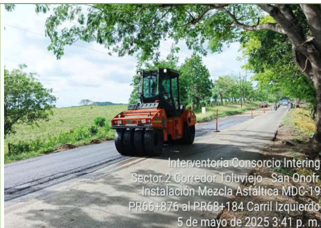
Interventoria Consorcio Interling Sector 2 Corredor Toluviejo - San Onofre Instalación Mezcla Asfáltica MDC-19 PR66+876 al PR68+184 Carril Izquierdo 5 de mayo de 2025 3:15 p. m.
