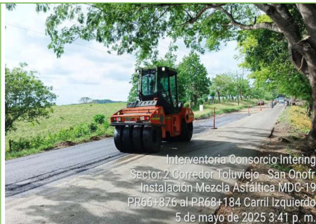
Interventoria Consorcio InterIng Sector 2 Corredor Tolviejo - San Onofre Instalación de Mezcla Asfáltica MDC-19 PR66+876 al PR68+184 Carril Izquierdo 5 de mayo de 2025 11:37 a. m.
