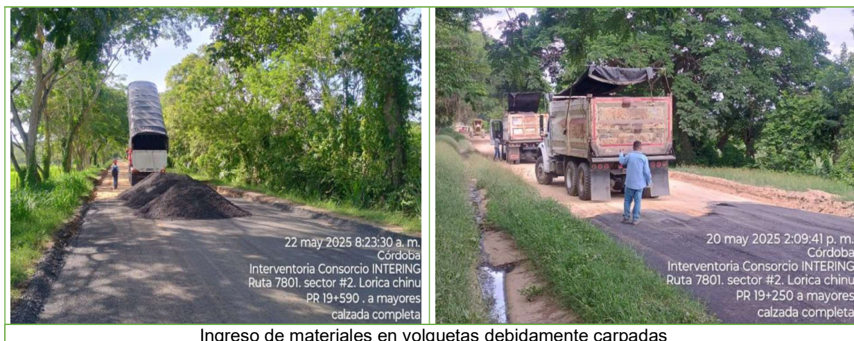
Ingreso de materiales en volquetas debidamente carpadas
