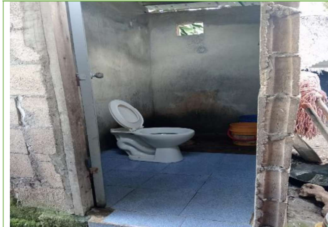
Unidad Sanitaria en el frente de obra de Lorica- Chinú
