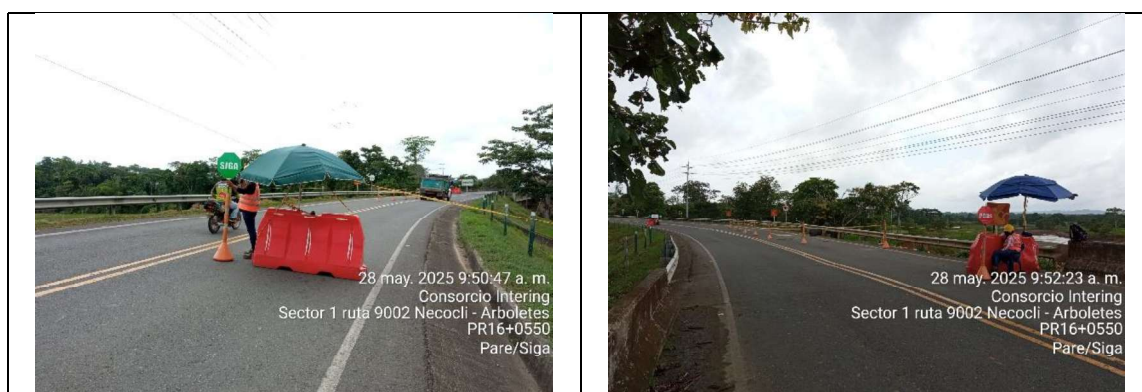
Ilustración 4 Señalización preventiva e informativa de obra Fuente. Registro fotográfico del Consorcio Interling
