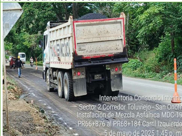
Interventoria Consorcio InterIng Sector 2 Corredor Tolviejo - San Onofre Instalación de Mezcla Asfáltica MDC-19 PR66+876 al PR68+184 Carril Izquierdo 5 de mayo de 2025 11:37 a. m.
