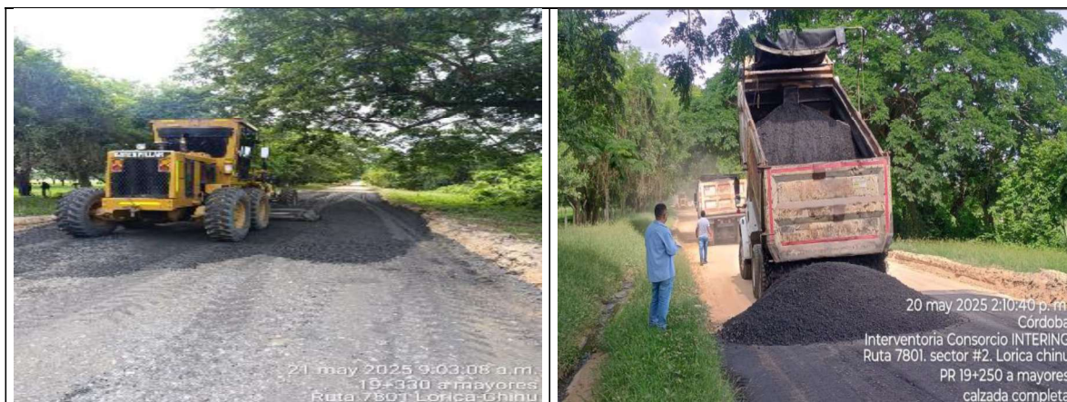
Fotos 19-20. Maquinaria y vehículos en frentes de obra
