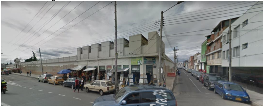
Figura 73. Sector Colindante – Carrera 29 A con Calle 68
