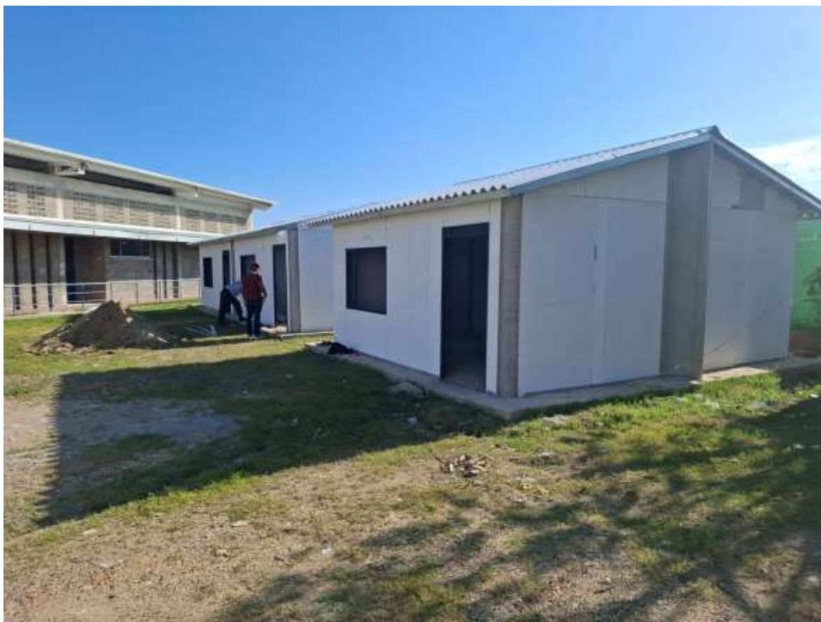
Foto 8. Finalización armado de aulas con de elementos del sistema celular eternit.
