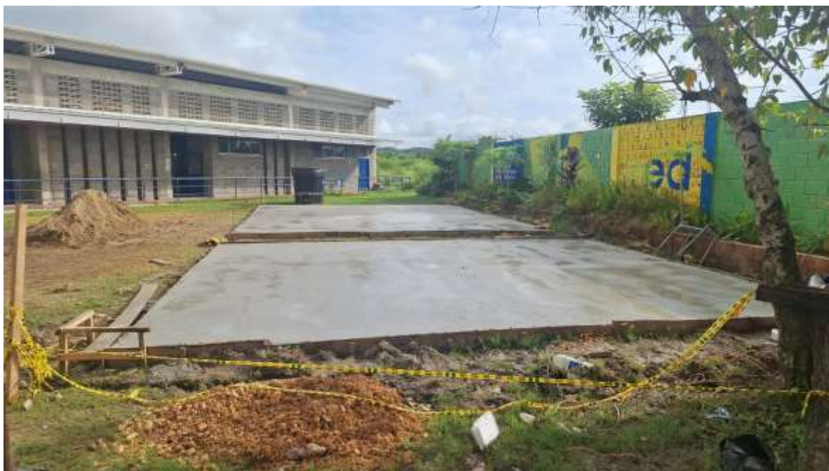
Foto 2. Vaciado placa contrapiso 3 aulas.
