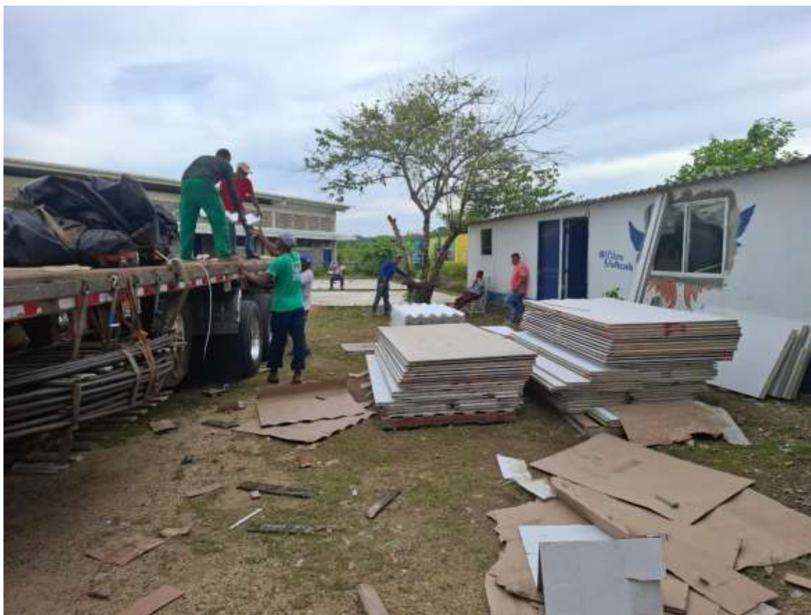
Foto 4. Descargue de elementos del sistema celular eternit.
