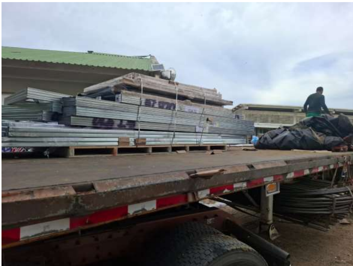
Foto 3. Arribo de elementos del sistema celular eternit.
