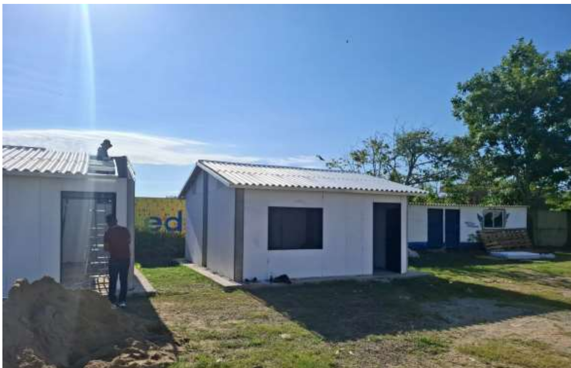
Foto 7. Armado de aulas con de elementos del sistema celular eternit.
