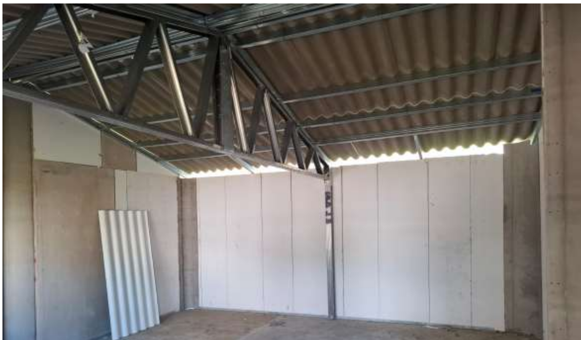
Foto 5. Armado de aulas con de elementos del sistema celular eternit.
