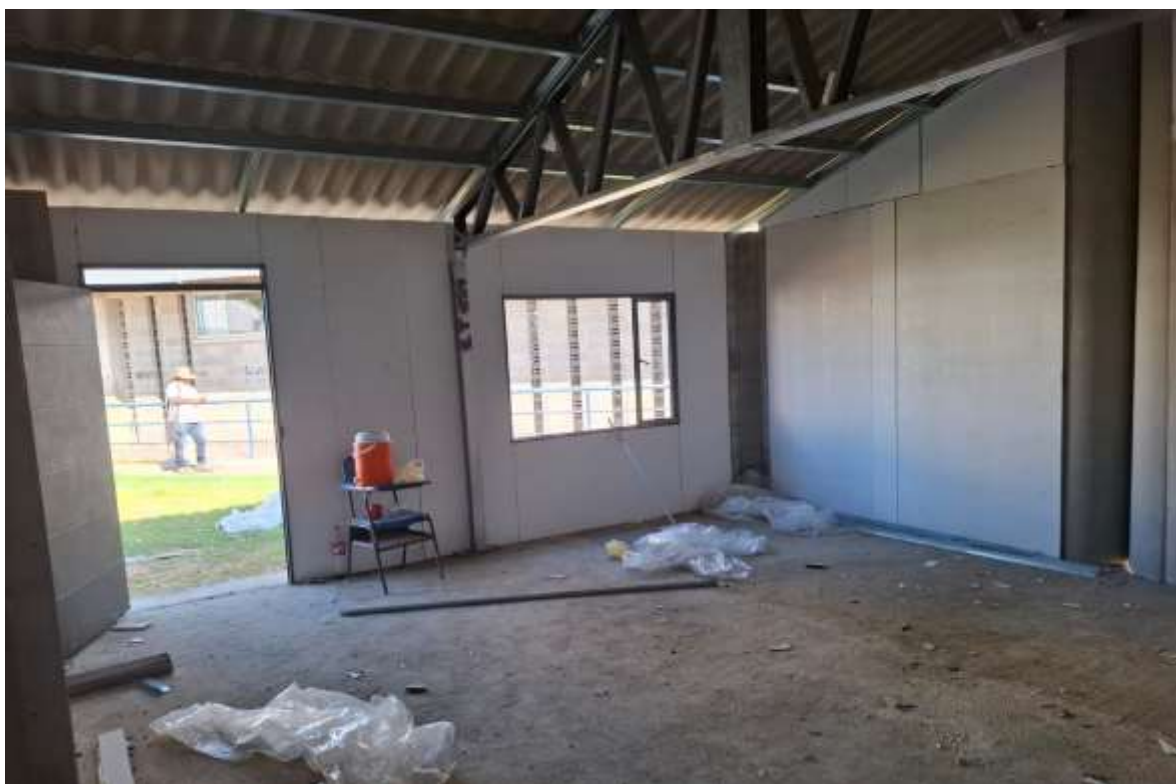
Foto 6. Armado de aulas con de elementos del sistema celular eternit.
