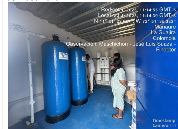
Fotografía 1. Cambio de bujías de microfiltración en el sistema de la comunidad de Maschichon.
