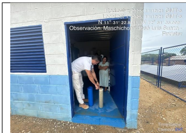
Fotografía 1. Cambio de bujías de microfiltración en el sistema de la comunidad de Maschichon.
