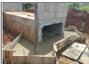
Concreto para losa de solera y zapatas de las aletas del box culvert K3+270 margen izq.
