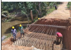
Acero para refuerzo del cuerpo del box culvert K2+410 margen izq.
