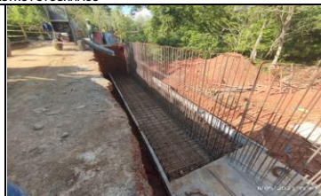
Acero para Zapata del muro contención K0+221.3/230.65 módulo 4, margen derecha, el anclor
