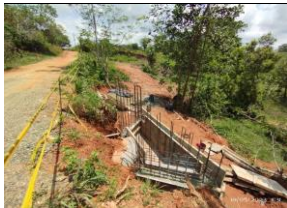
Instalación de formaleas para aletas de la alcantarilla K4+290 margen derecha.
