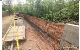
Acero para refuerzo de vástago muro contención K0+330/350 margen derecha, módulo 4.
