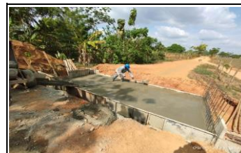
Concreto para losa superior del box culvert K3+270 ancho de calzada, el anclor
