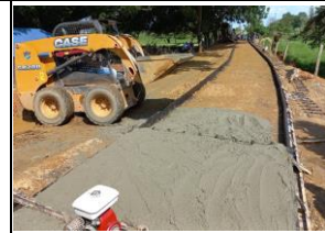
Instalación de concreto Hidraulico tipo MR - 40 entre ABS K5+392/458 margen izq. Alineamiento
