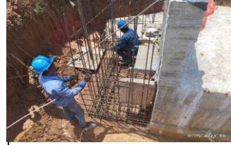
Acero para refuerzo de caja de recibo para box culvert K3+270 margen derecho.
