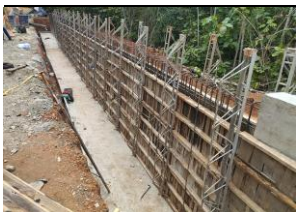
Instalación de formaletas para vástago muro contención K0+330/350 Margen derecha, módulo 4.
