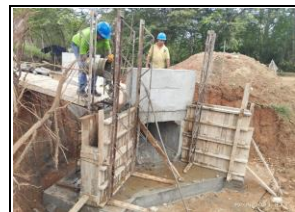
Concreto para aletas del box culvert K1+280 margen derecho, El Anclar
