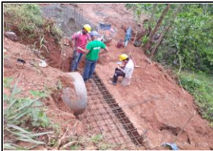
Acero de refuerzo para aletas de la alcantarilla K4+290 margen derecha, El anclor
