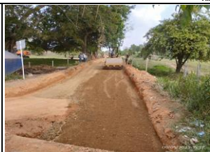
Mejoramiento con material granular para el empalme de pavimento existente lineamiento 6 del K5+42 al K5+458, el pindo
