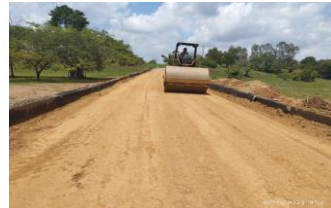
Compactación de material para subbase Alineamiento 6.
