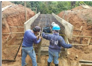
Instalación de formaletas para losa superior del box culvert K1+280 ancho de calzada, el anclor
