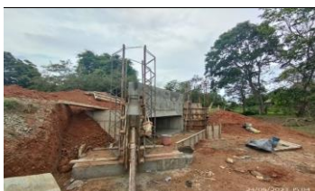
Concreto para aletas del box culvert K3+945 margen derecho, el anclar
