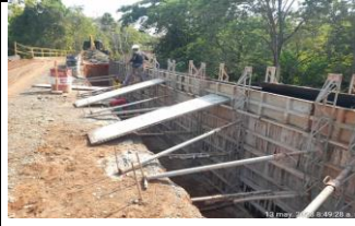
Encofrado vástago Módulo 3, muro K0+190/230 MD, el Ancilar
