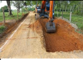
Excavación para mejoramiento de calzada, tramo pindo, alineamiento 5, k+106-45+138
