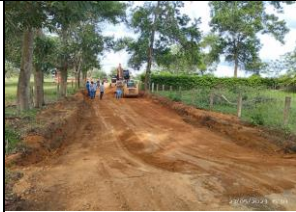
Excavación para mejoramiento del empalme pavimento nuevo al existente, entre las Abs K3+561/529 ancho de calzada, Alineamiento 3, Tramo El Pindo
