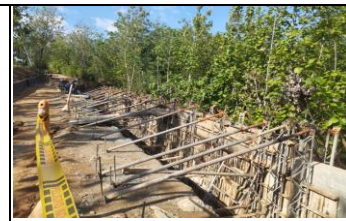
Instalación de formaletas para vástago muro contención K0+310/330, módulo 3, margen derecho, el anclor
