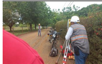
Control topografico por parte de interventoria actividades de pavimento, el pindo
