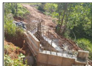
Concreto para aletas y pantalla de la alcantarilla K4+290 margen derecho
