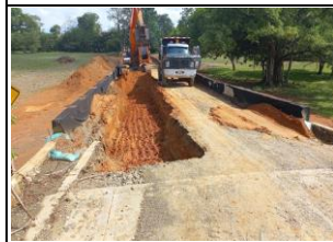
Excavación para mejoramiento de calzada, tramo pindo, alineamiento 6 del K5+285/317
