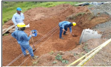
Replanteo para concreto de solado de la solera de la alcantarilla K4+860 margen izquierda, el anclor
