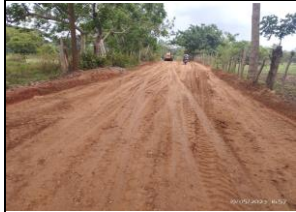
El contratista realiza extendida de material granular en el alineamiento 1 desde la ABS K1+500 hasta K1+650
