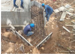
Acero para refuerzo de losa de solera y zapatas para aletas del box culvert K1+280, margen derecha.
