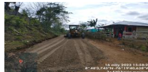
Extendida de subbase tramo 6
