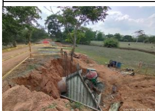
Concreto para losa de solera de Alcantarilla K3+901 margen derecha, el anclor
