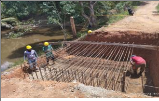
Acero para refuerzo del cuerpo del box culvert K2+410 margen izq.
