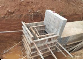
Instalación de formaleas para caja de recibo del box culvert K0+944 margen derecha.
