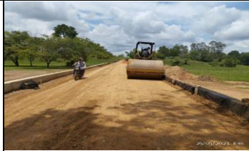
Densificación sub base granular alineamiento 6, K 5+282/390, El pindo.
