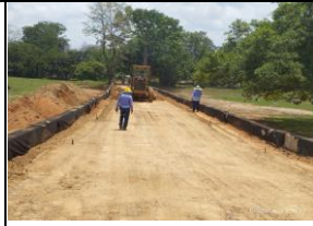
Extendida y compactación de material granular para el alineamiento 6 del tramo Pindo.
