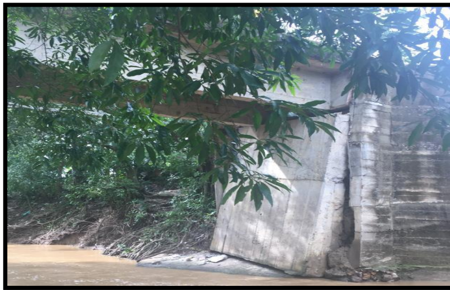
Imagen 5. Puente existente via Tierralta, K0+275
