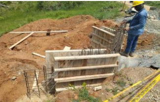
Acero para refuerzo de aletas y pantalla para la alcantarilla K4+860 margen izq.
