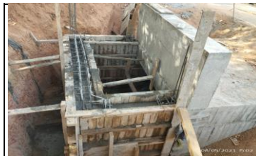
Concreto para caja de recibo de box culvert K1+805 margen izq, el anclor
