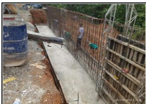
Acero para refuerzo de vástago muro contención K0+350/362.6 módulo 5, margen derecho.
