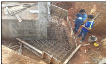
Acero para refuerzo de solera y Zapata para aletas del box culvert K0+944 margen izq
