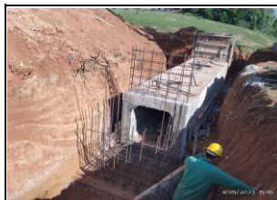
Acero refuerzo caja de recibo y guardaruedas del Box culvert K0+944 margen derecha, el anclor
