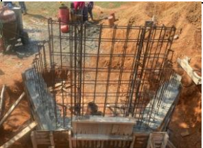
Concreto para aletas y pantalla de la alcantarilla K3+901 margen derecho. El Ancilar
