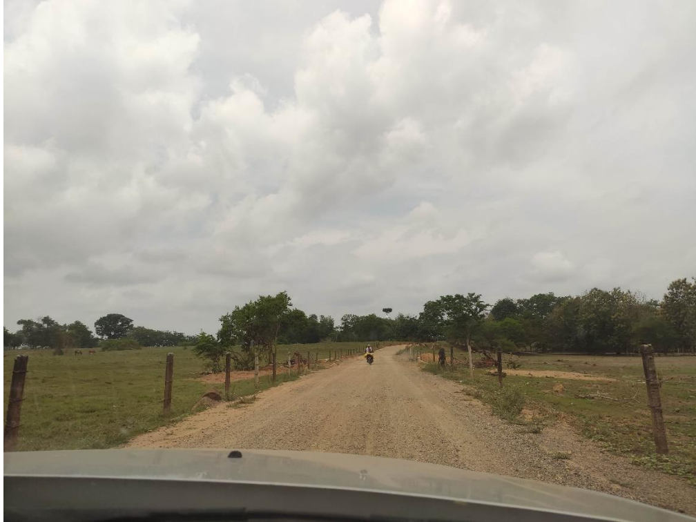
Se avanza en la Explanación de la Rasante actual para el inicio de la colocación del Terraplén variable.
