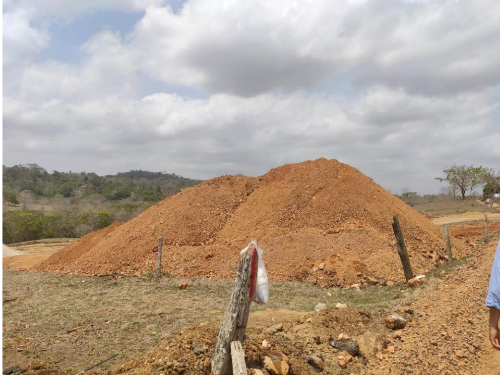
Acopio de Material de la cantera Loma Grande, al que se le debe realizar seguimiento, dado que se tienen dudas del cumplimiento de la Plasticidad.
