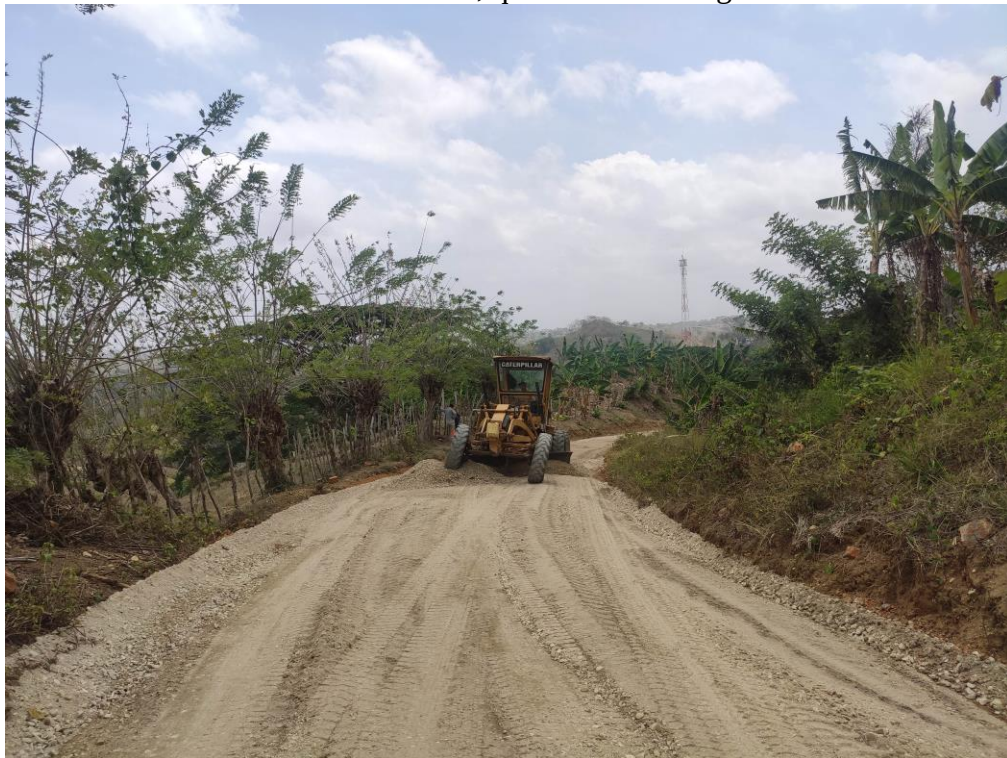
Extensión para la conformación de la Subbase Granular.
