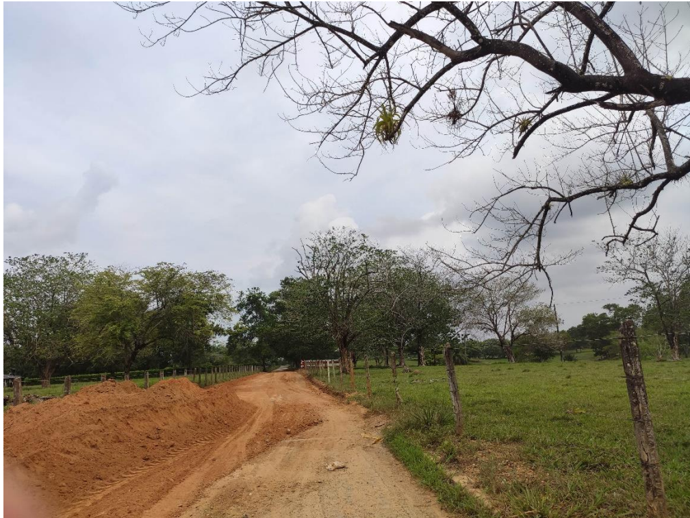
Materiales removidos para la perfialción y ensanchamiento del corredor.
