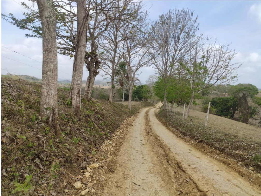
Zona de reserva ambiental en donde a la fecha no se sabe si se construirá la Estructura de Pavimento.
