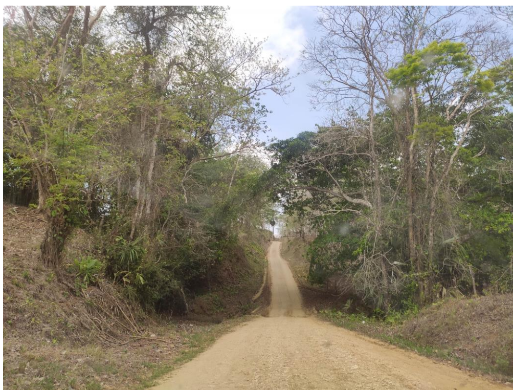
Zona de inicio de la Pavimentación con Estructura de Pavimento Flexible.
