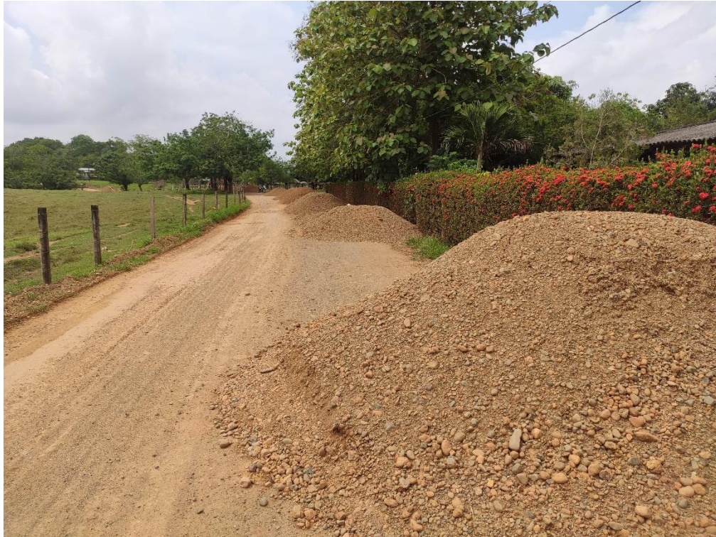
Material para construir el Terraplén variable, extendido en la vía.
