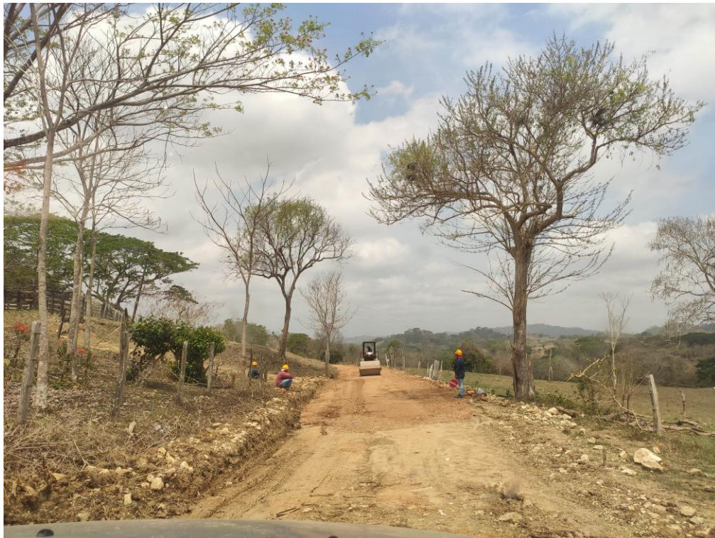
Mejoramiento colocado sobre el Geotextil T, con material de la Cantera Loma Grande.
