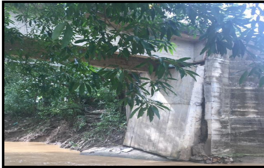
Imagen 5. Puente existente via Tierralta, K0+275
