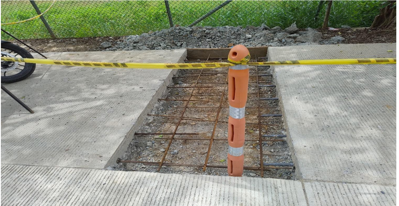
Tercio de losa a reparar, instalación del refuerzo.
