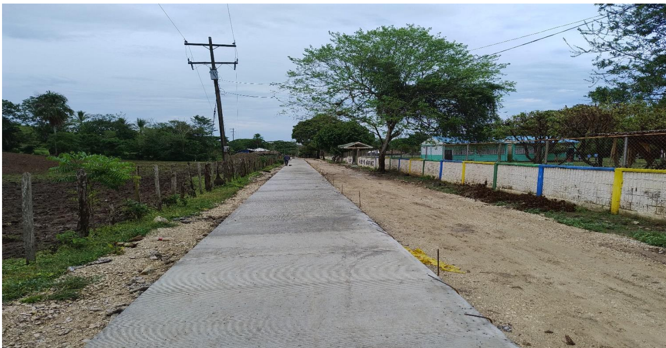
K6+140 Obsérvese el buen acabado superficial y la limpieza de la obra a pesar del Invierno
