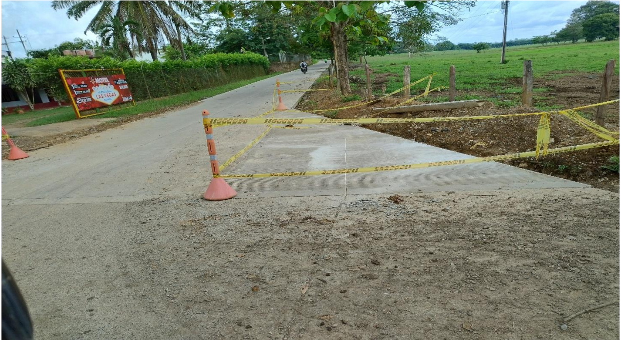
Fin de la Construcción del Pavimento Rígido PR0+000.
