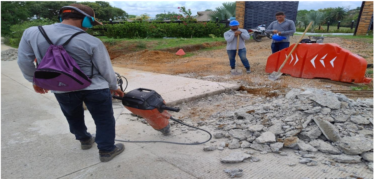
Demolición de Losas Fisuradas.
