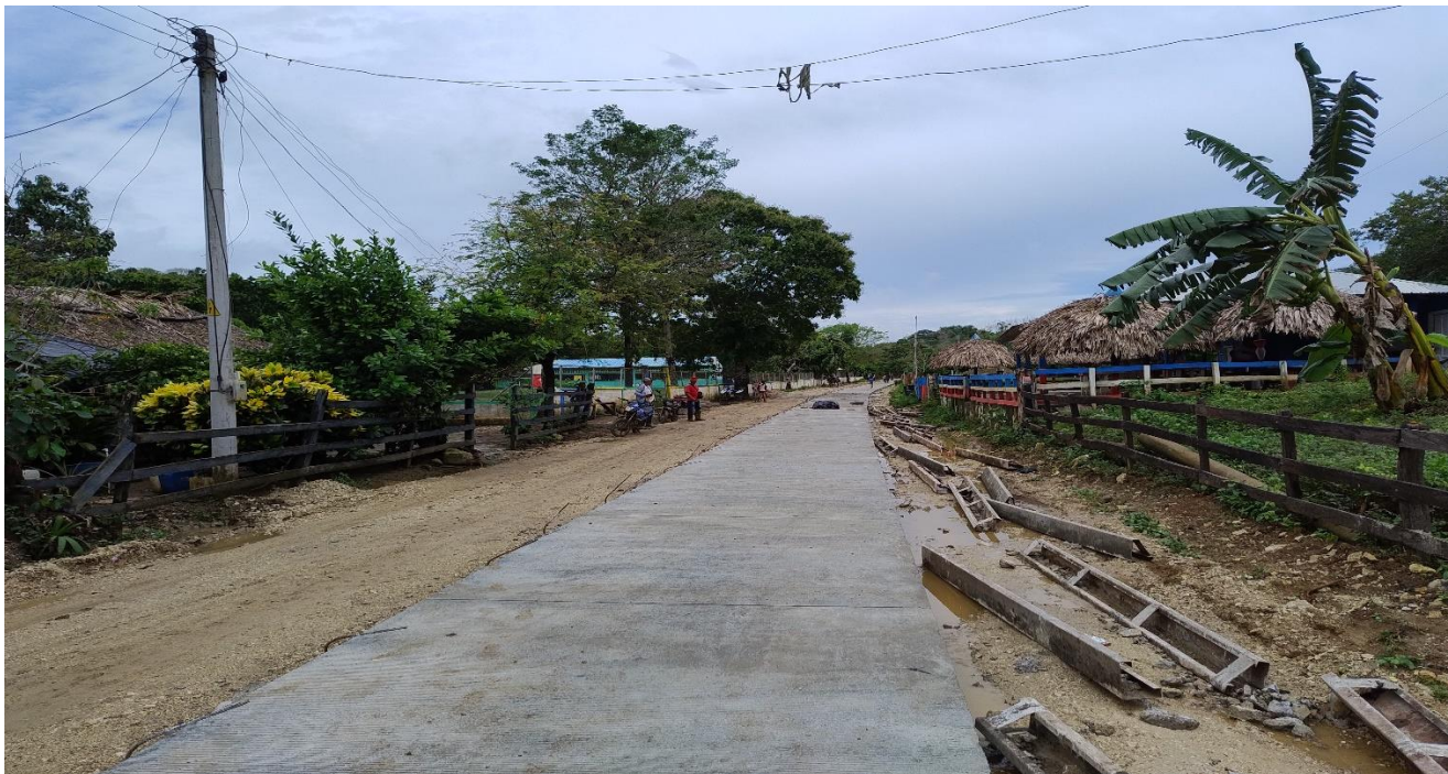
K6+350, observando el Pavimento Rígido, en el Sentido contrario, pero siendo siempre el mismo carril
