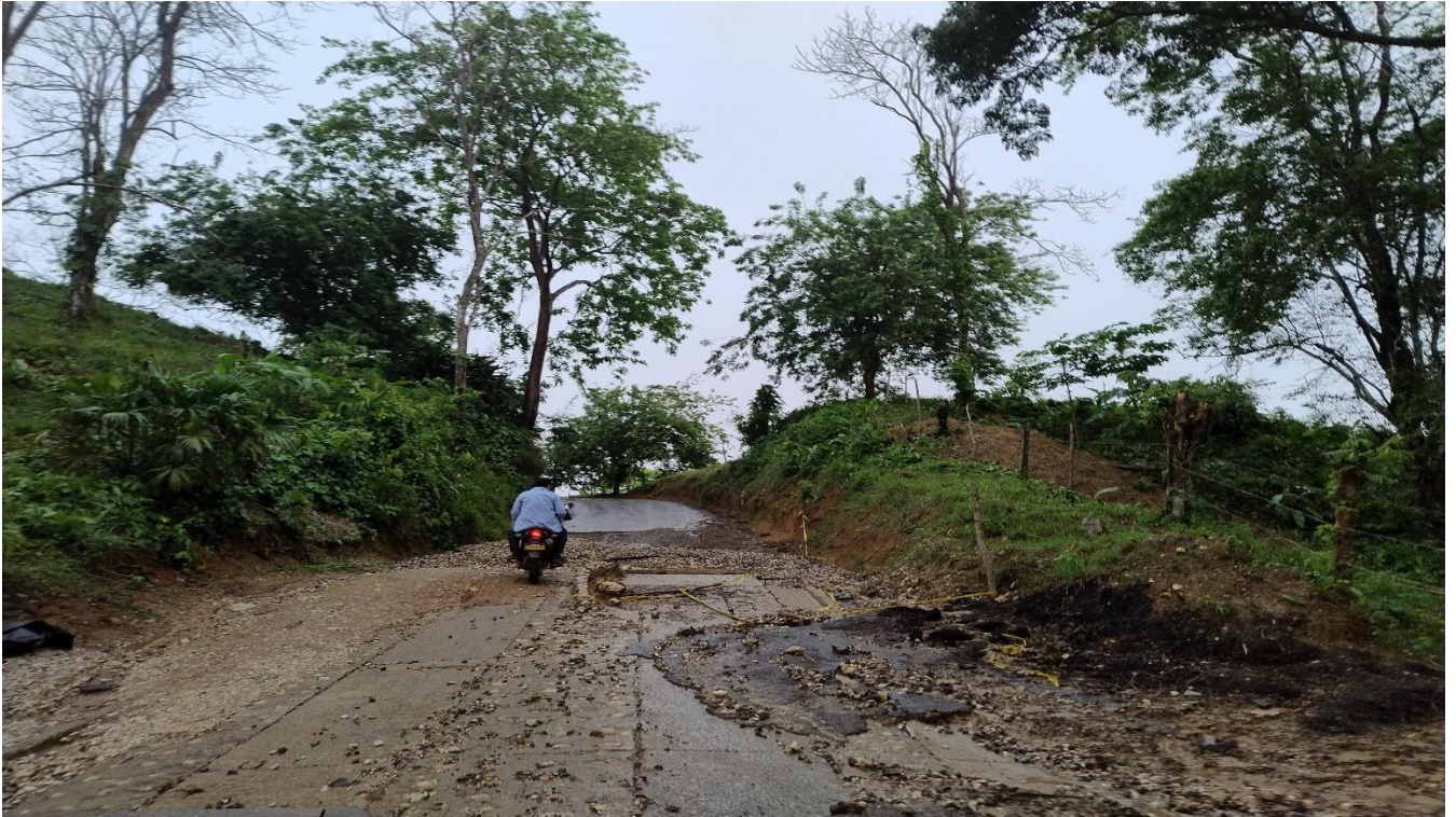
Empalmes no concluidos en pendientes fuertes que generan inseguridad y riesgo de accidentes.
