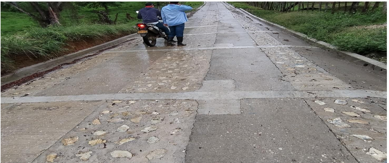
Reparaciones puntuales en la Placa Huella dañada por el Trafico que circula en la zona.
