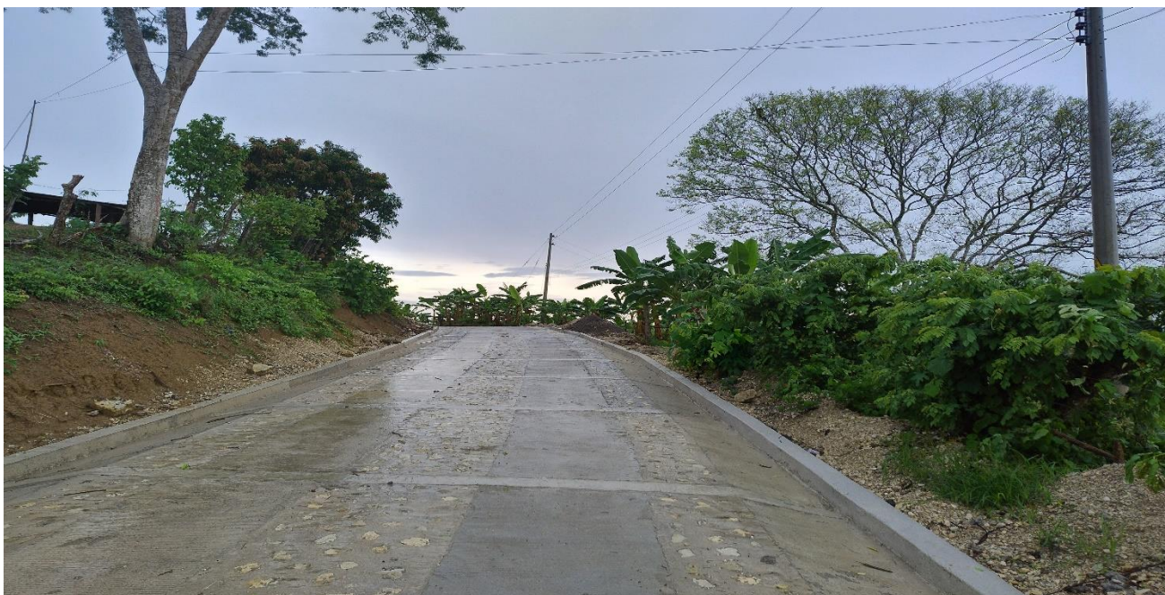
Ultimo tramo de Placa huella, sin novedades.
