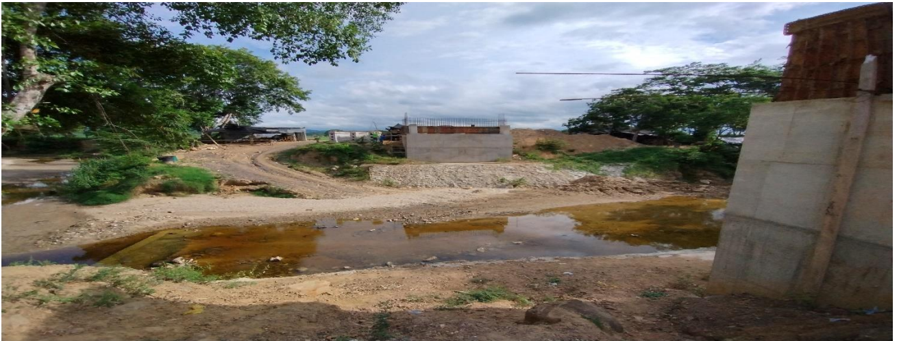
Estructura de apoyo de las Vigas del Puente QUEBRADA LA SEREVINERA
