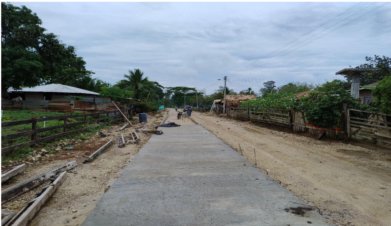
K6+450, PUERTO NARIÑO, abscisa donde avanza la construcción
