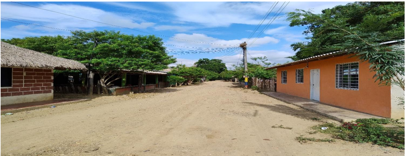
Corredor de la vía proyectada en el Caserío de la SEREVINERA
