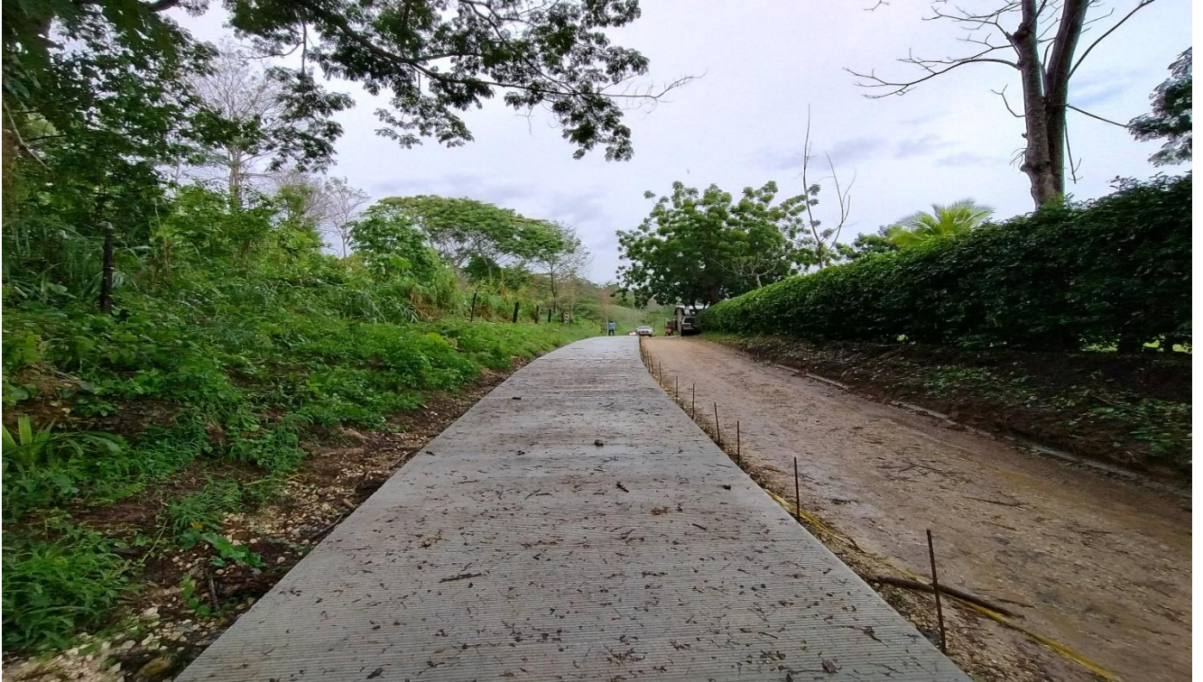
K 5+590 inicio de construcción del Pavimento Rígido.
