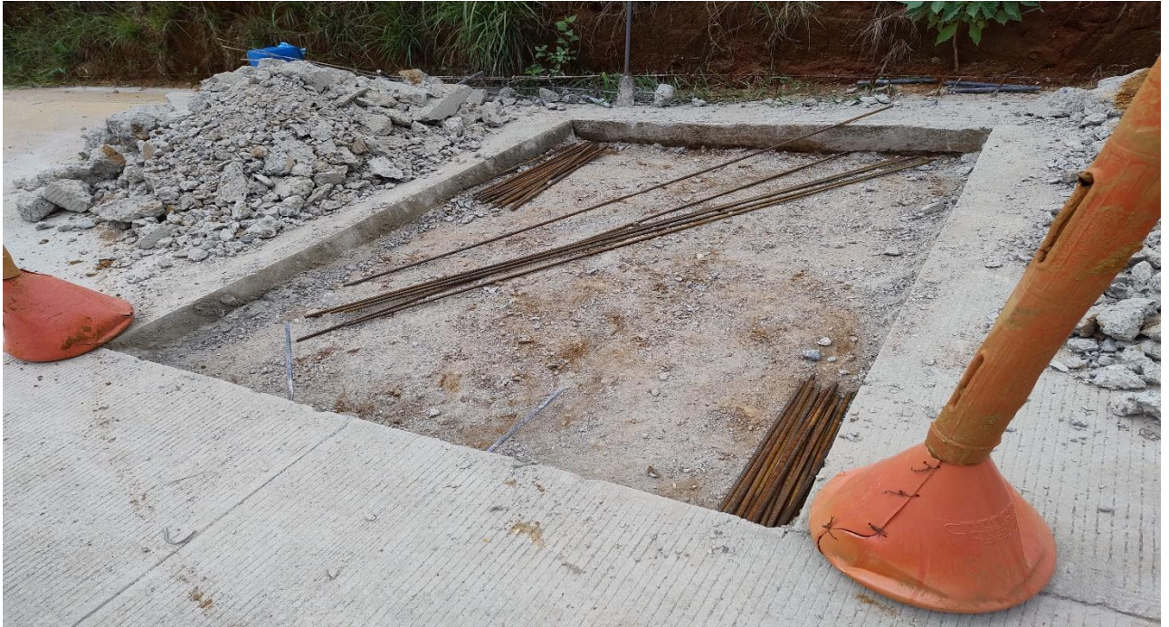
Reparación de 2 losas continuas cada una al tercio medio
