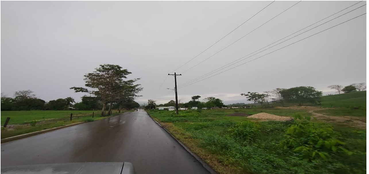
Mirando hacia el K0+000, Pavimento Flexible sin novedad y en servicio.
