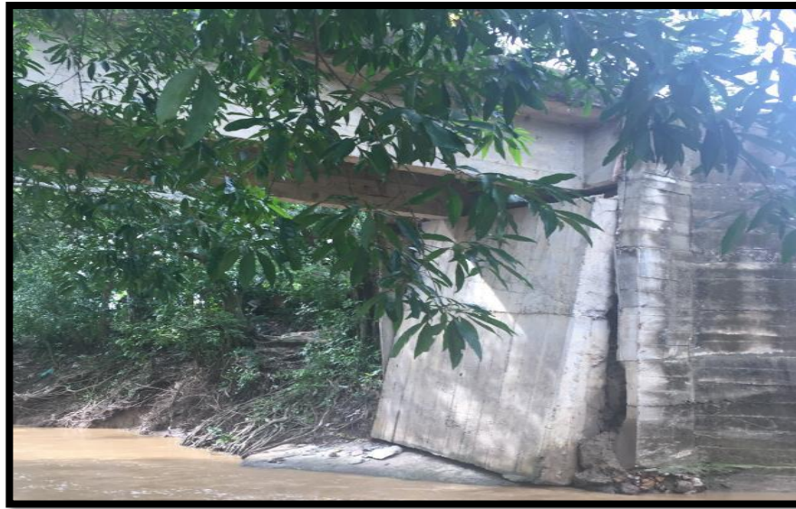
Imagen 5. Puente existente via Tierralta, K0+275
