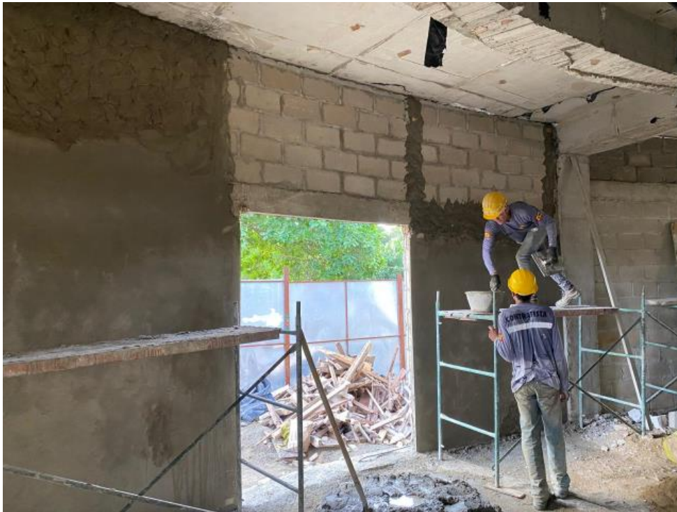
Ilustración 25. Pañete baños graderías de softbol
