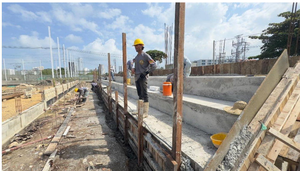
Ilustración 43. Fundida concreto 4000 psi placa y escalones graderías cancha futbol 9
