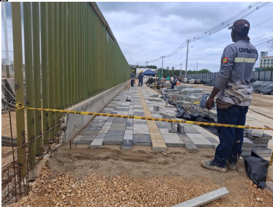
Ilustración 50. Instalación losetas
