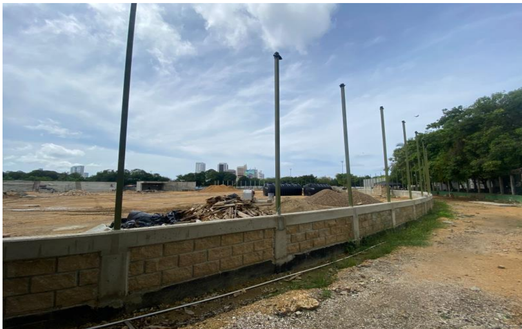
Ilustración 22. Levante en Block No 6 cerramiento cancha de softbol
