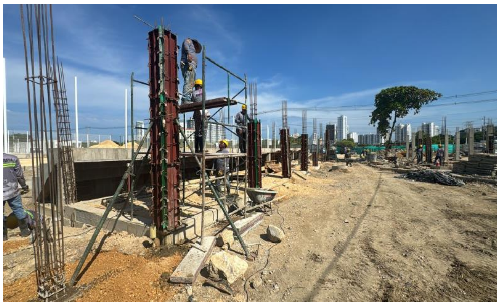
Ilustración 40. Figurado acero de refuerzo de 60.000 psi columnas baños y camerinos cancha futbol 9
