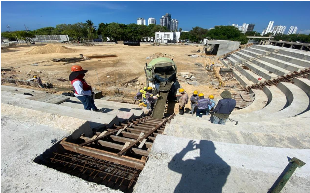
Ilustración 18. Fundida concreto 4000 escaleras graderías cancha de softbol CONSORCIO INTERDEPORTIVO NCH NIT 901860846-1
