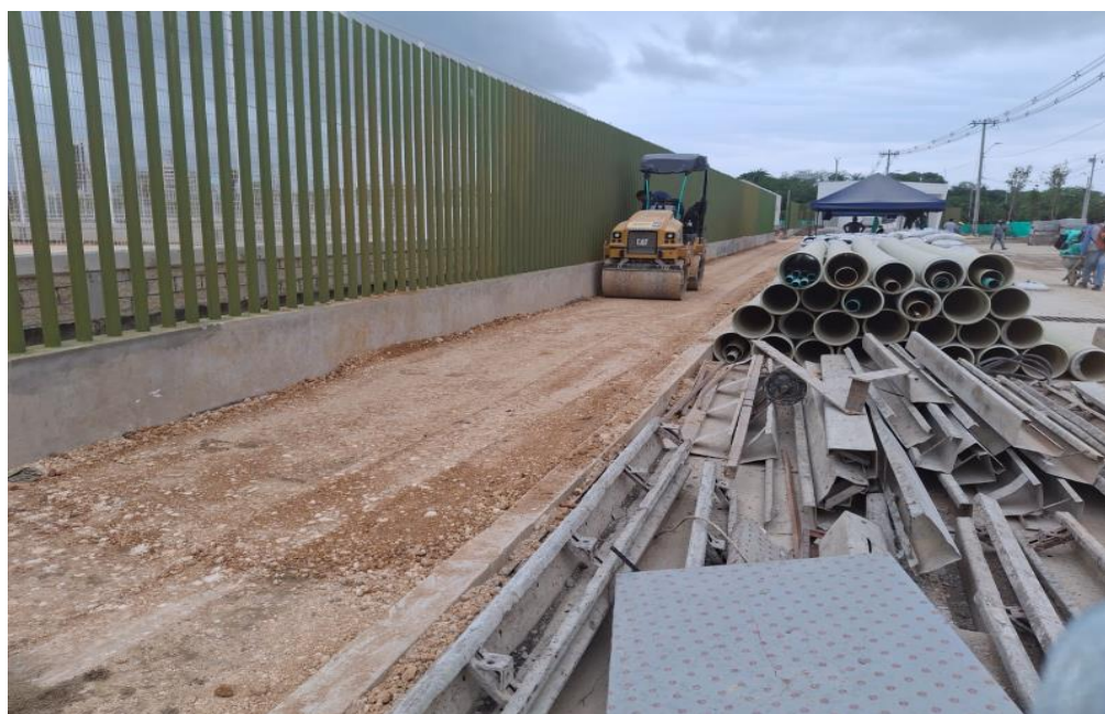
Ilustración 36. Relleno y compactación material seleccionado para acondicionamiento e instalación losetas zona peatonal
