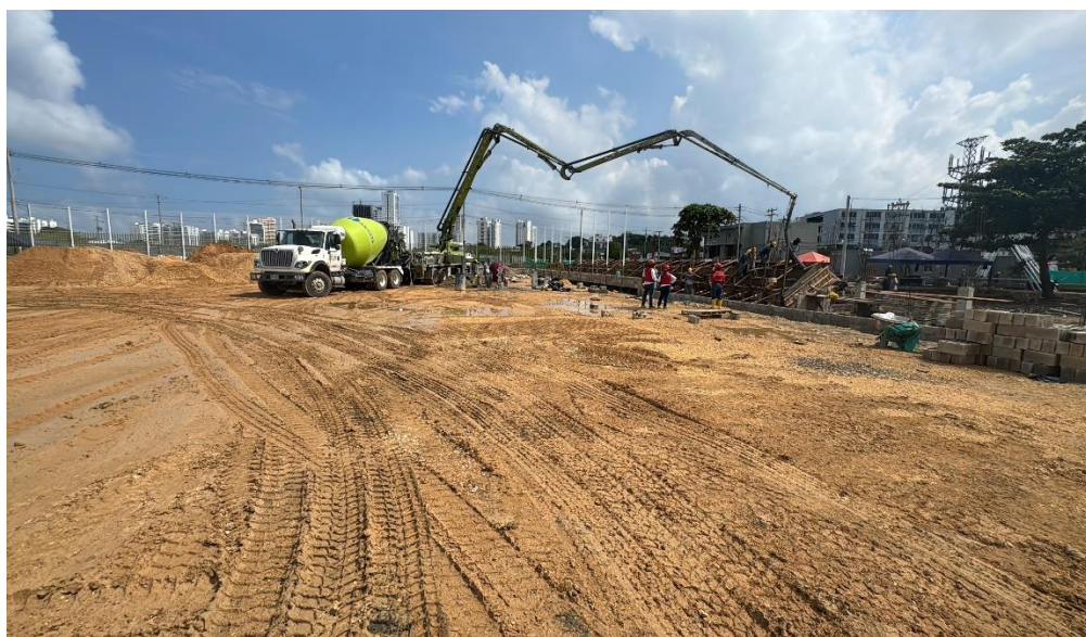
Ilustración 42. Fundida concreto 4000 psi placa y huellas escalinatas futbol 9
