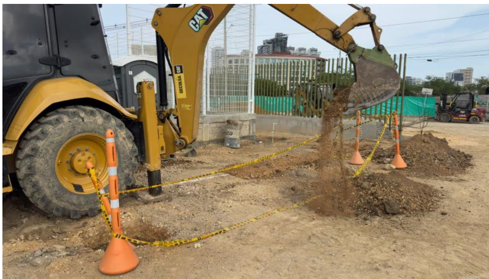
Ilustración 31. Excavación mecánica para instalación de tuberías eléctricas
