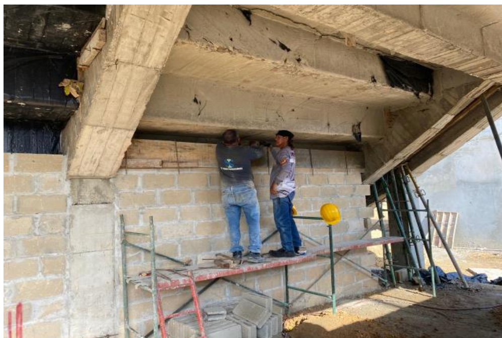
Ilustración 24. Levante en block No 4 baños graderías de softbol
