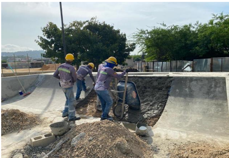
Ilustración 19. Fundida concreto 4000 psi rampa de skatepark
