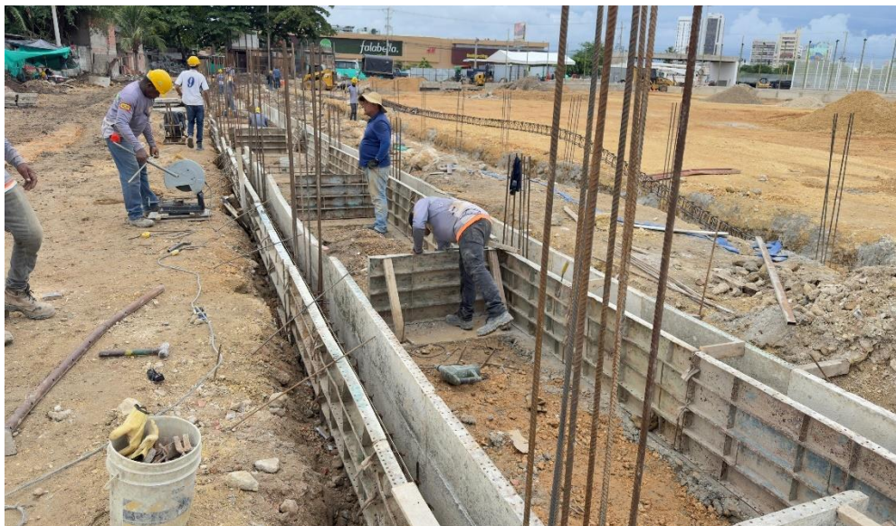
Ilustración 39. Figurado acero de refuerzo de 60.000 psi vigas y columnas baños y camerinos cancha futbol 9
