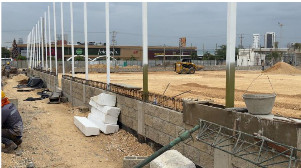
Ilustración 38. Figurado acero de refuerzo 60.000 psi viga confinamiento cerramiento cancha futbol 9
