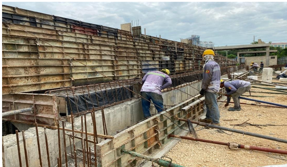
Ilustración 14. Figurado acero 60000 psi graderías de futbol
