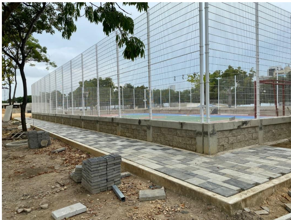
Ilustración 27. Instalación losetas circulación cancha múltiple
