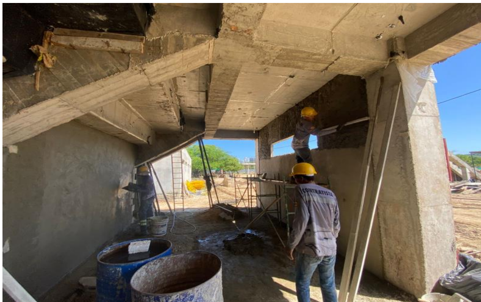
Ilustración 26. Pañete baños graderías de softbol
