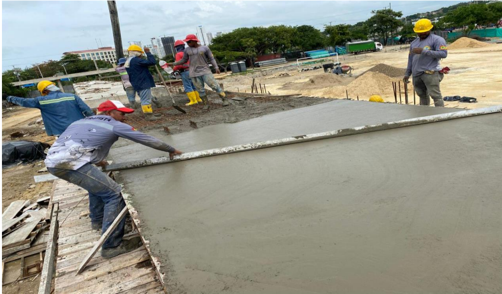
Ilustración 17. Fundida concreto 4000 psi placa y vigas graderías cancha de futbol
