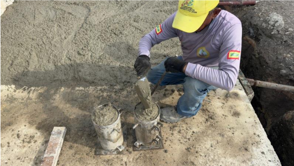
Ilustración 54. Toma de muestras concreto 4000 psi para mástiles
