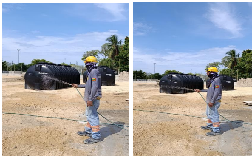
Ilustración 67. Riego de agua contra el polvo
