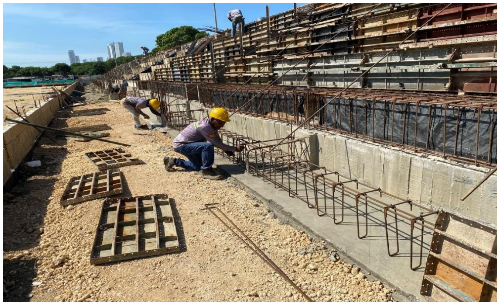
Ilustración 15. Figurado acero 60000 psi vigas y placa graderías cancha de futbol
