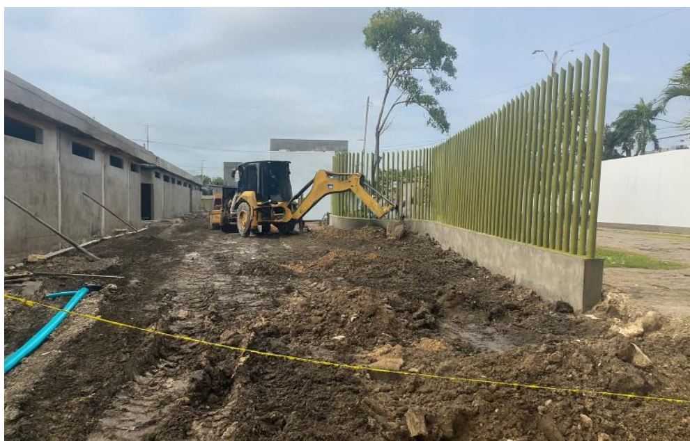
Ilustración 32. Excavación para conformación de urbanismo
