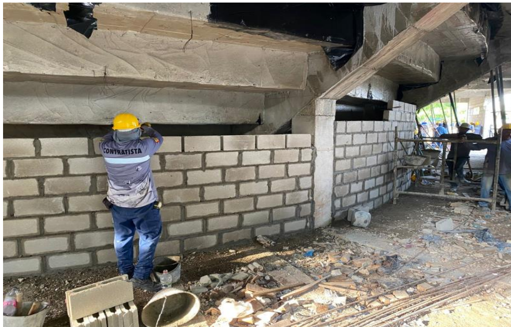
Ilustración 23. Levante en block No 4 baños graderías de softbol
