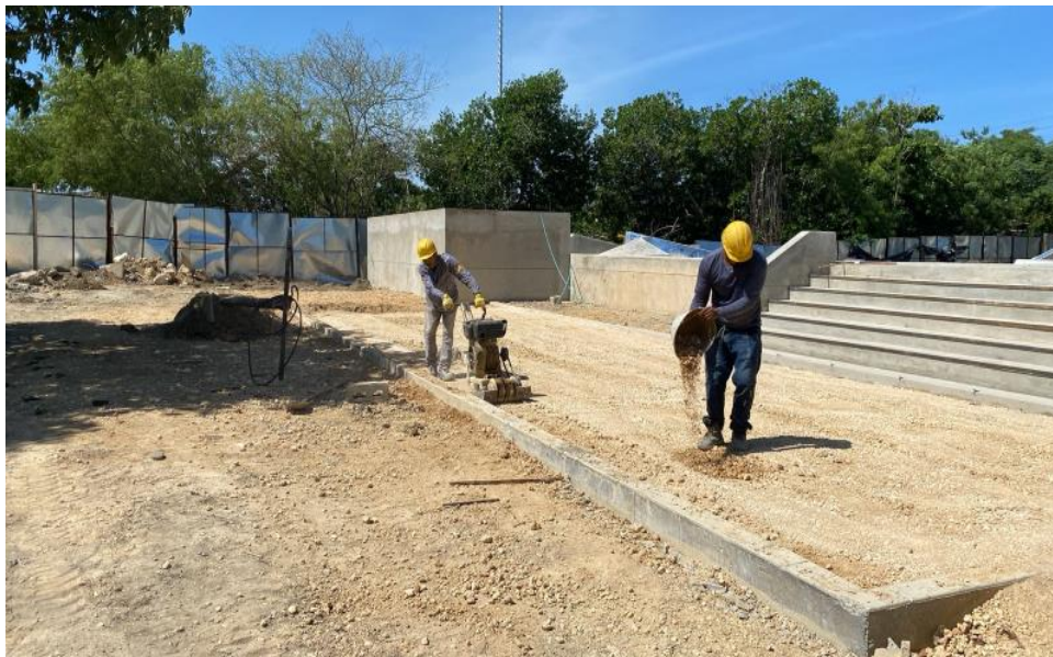
Ilustración 12. Relleno y compactación material seleccionado zona de skatepark
