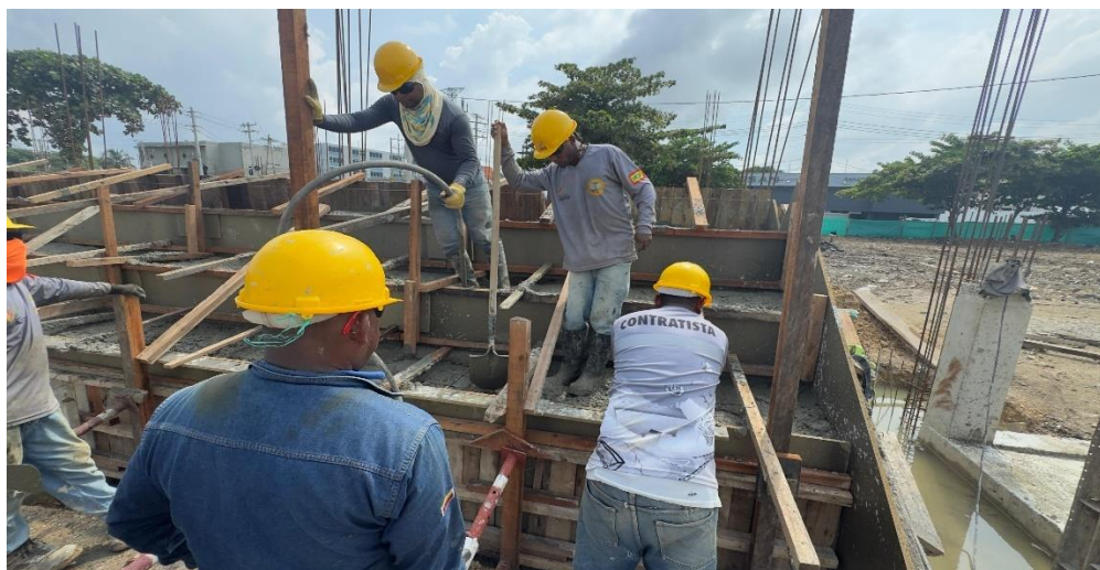
Ilustración 41. Fundida concreto 4000 psi escalinatas cancha futbol 9
