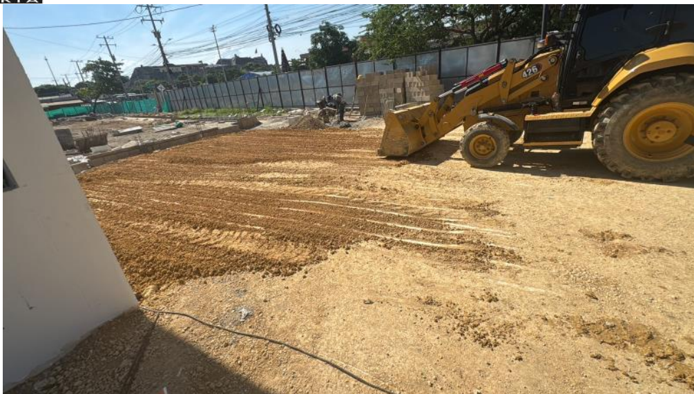
Ilustración 35. Relleno y compactación material seleccionado para acondicionamiento acceso principal
