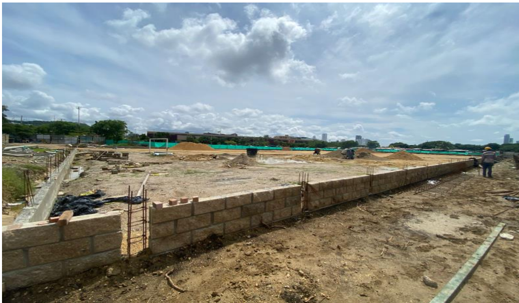
Ilustración 21. Levante en Block No 6 cerramiento cancha de futbol
