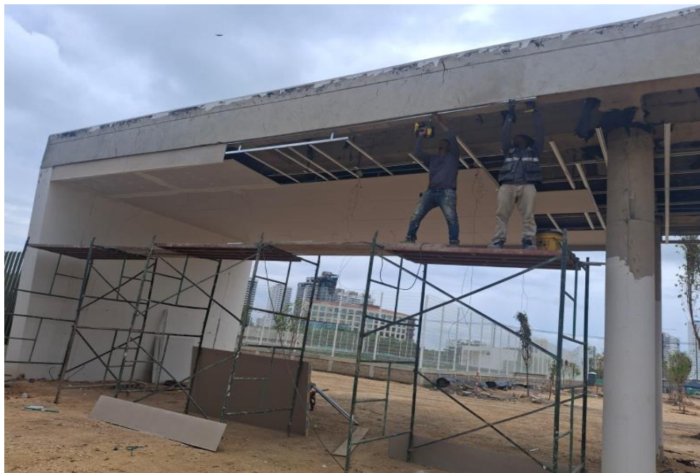
Ilustración 52. Instalación cielo raso acceso principal
