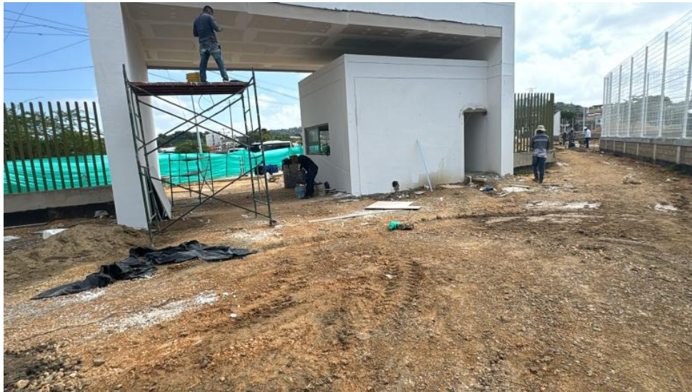
Ilustración 51. Estuco exterior y cielo raso acceso zona parqueaderos
