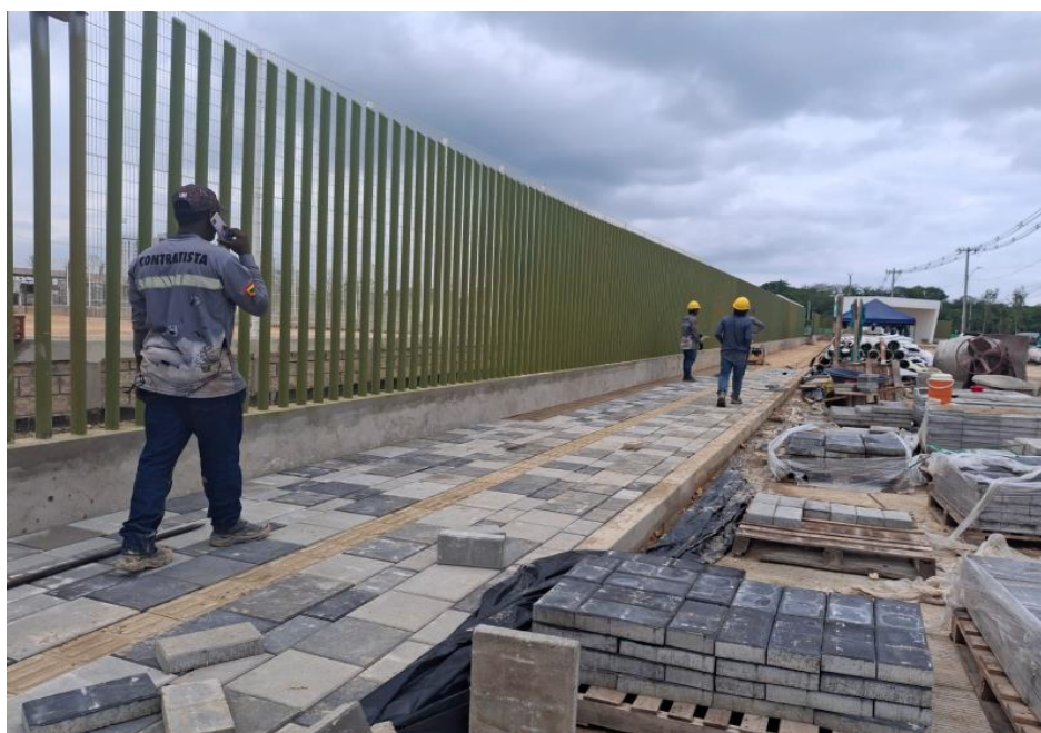
Ilustración 50. Instalación losetas
