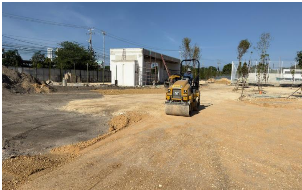
Ilustración 34. Relleno y compactación material seleccionado zona de niños
