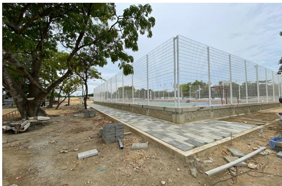
Ilustración 28. Instalación losetas circulación cancha múltiple
