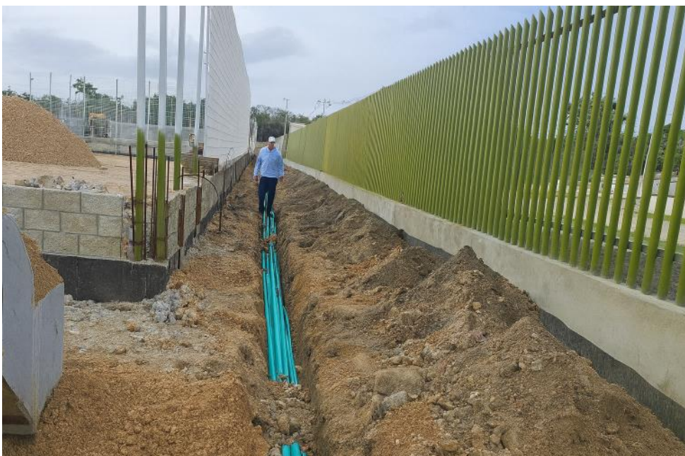
Ilustración 48. Instalaciones tuberías eléctricas
