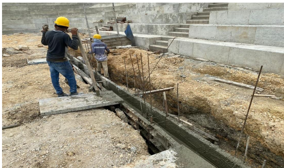
Ilustración 20. Fundida concreto 4000 psi viga de cimientos cerramiento cancha de softbol
