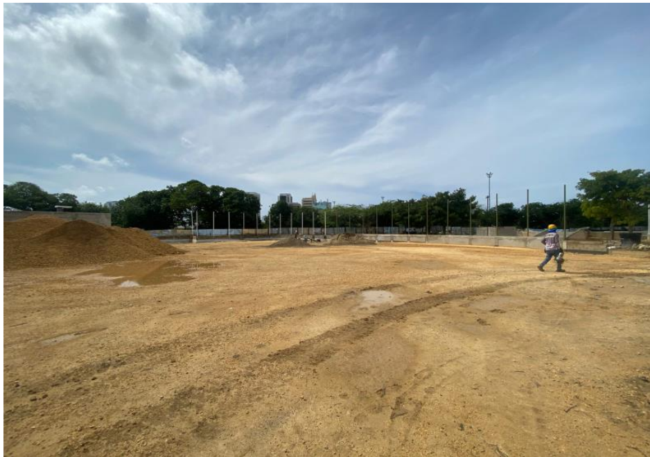
Ilustración 10. Relleno y compactación material seleccionado cancha de softbol.
