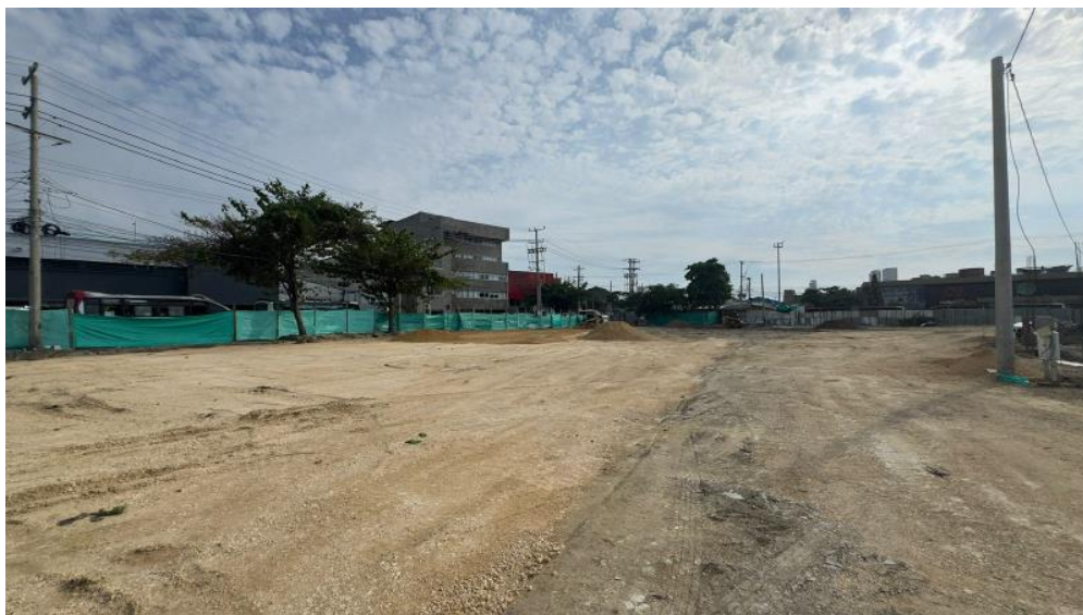
Ilustración 33. Relleno material seleccionado área recuperada
