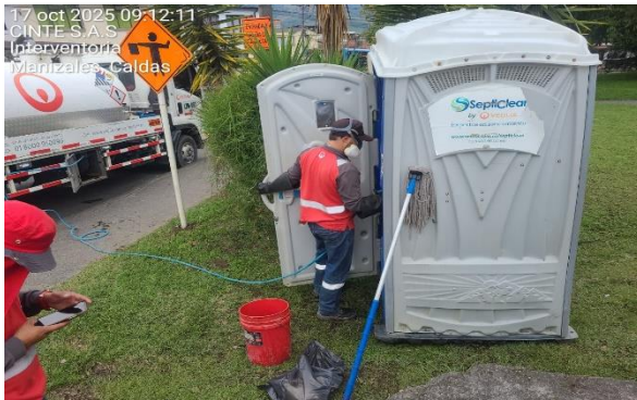
INSPECCION LIMPIEZA DE BAÑO P.
