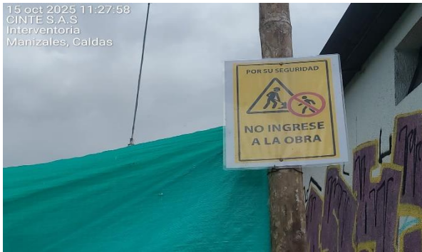
SEÑALIZACIÓN RIESGOS EN OBRA
