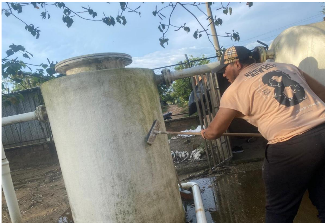
Lavado del tanque con el fin de remover lama, musgo para evitar la concentración de malos olores
