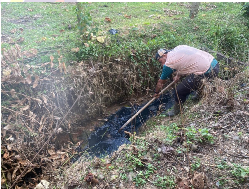
Limpieza de la cuneta de descargue del agua residual ya tratada de la PTAR
