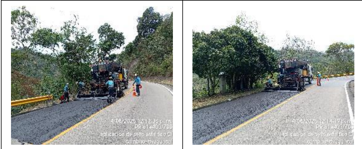
PR61+400 al PR61+700 Instalación de Slurry seal– costado izquierdo
