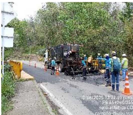
PR66+268 al PR66+355 Instalación de Slurry seal– costado derecho
