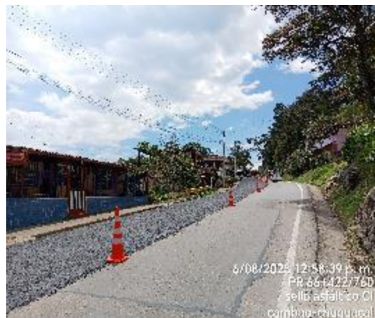
PR66+422 al PR66+760 Instalación de Slurry seal– costado izquierdo
