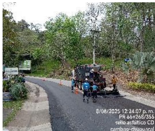
PR66+268 al PR66+355 Instalación de Slurry seal– costado derecho
