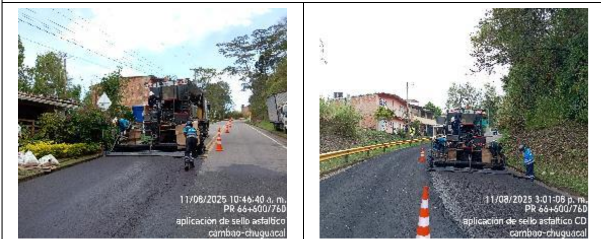
PR66+600 al PR66+760 Instalación de Slurry seal– Ambos costados
