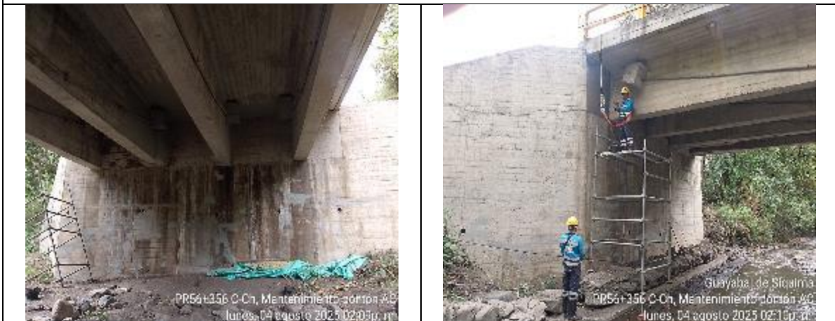
PR56+356 Mantenimiento Pontón – ambos costados
