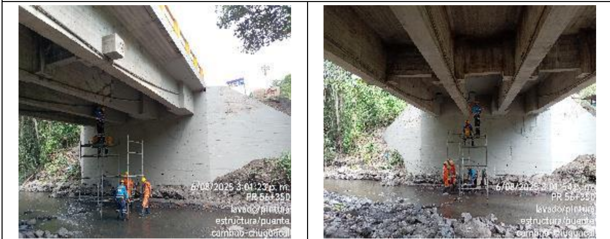
PR56+356 Mantenimiento Pontón – ambos costados
