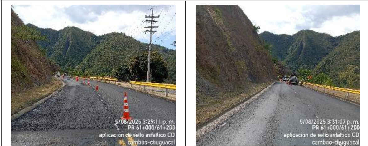
PR61+000 al PR61+200 Instalación de Slurry seal– ambos costados
