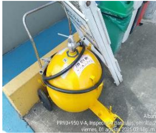
Alban PR93+950 V-A, Inspección Basculas, sentido 2 viernes, 01 agosto 2025 02:13p. m.
