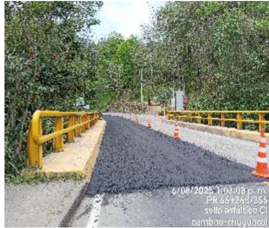
PR66+268 al PR66+355 Instalación de Slurry seal– costado izquierdo
