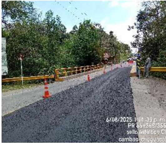
PR66+268 al PR66+355 Instalación de Slurry seal– costado izquierdo
