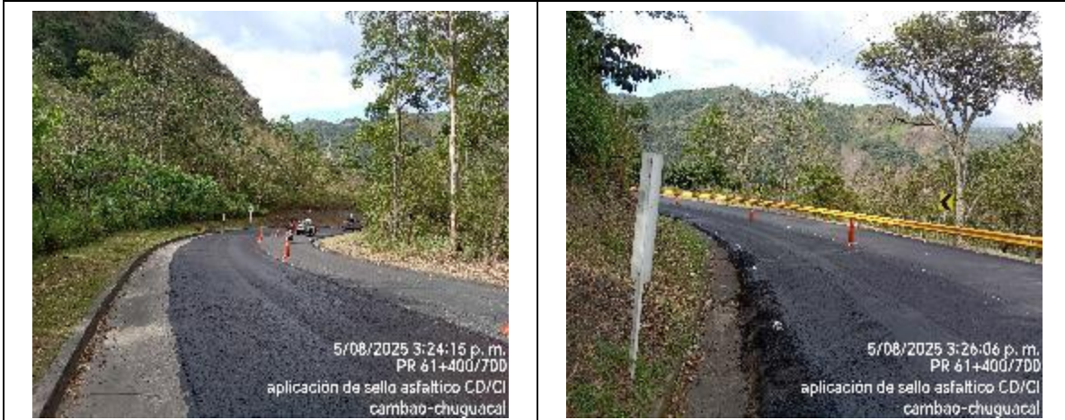
PR61+400 al PR61+700 Instalación de Slurry seal– costado derecho
