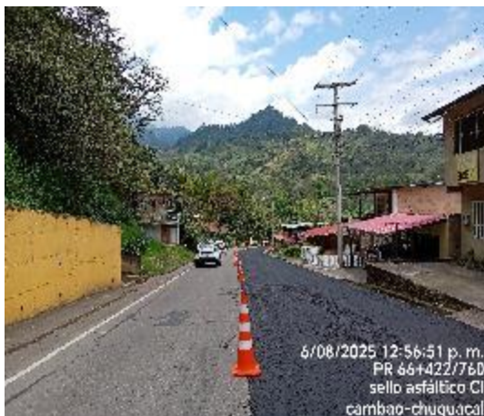
PR66+422 al PR66+760 Instalación de Slurry seal– costado izquierdo
