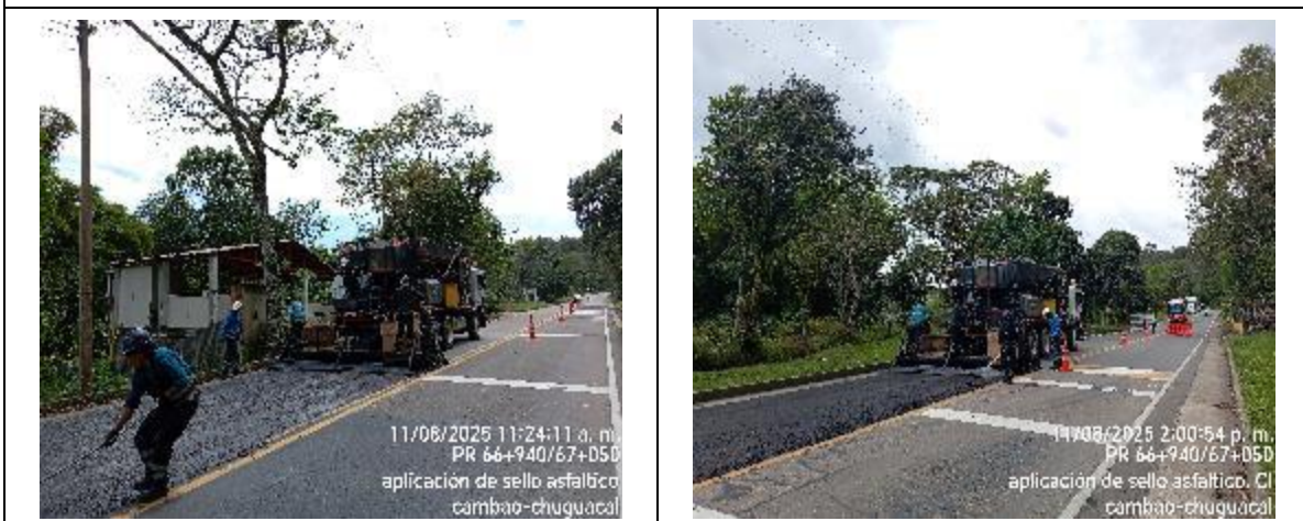
PR66+940 al PR67+050 Instalación de Slurry seal– Ambos costados
