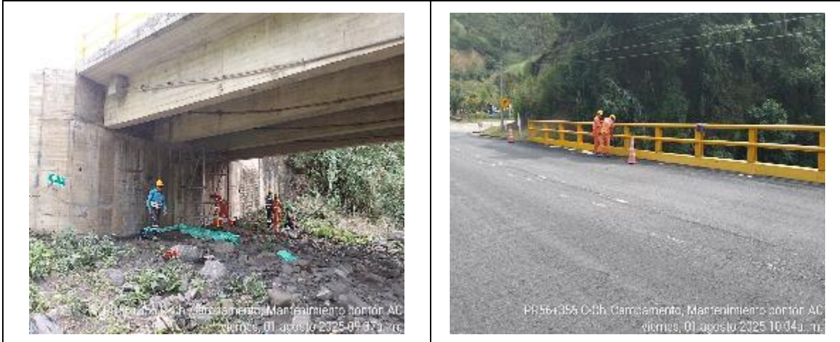
PR56+356 Mantenimiento Pontón – ambos costados
