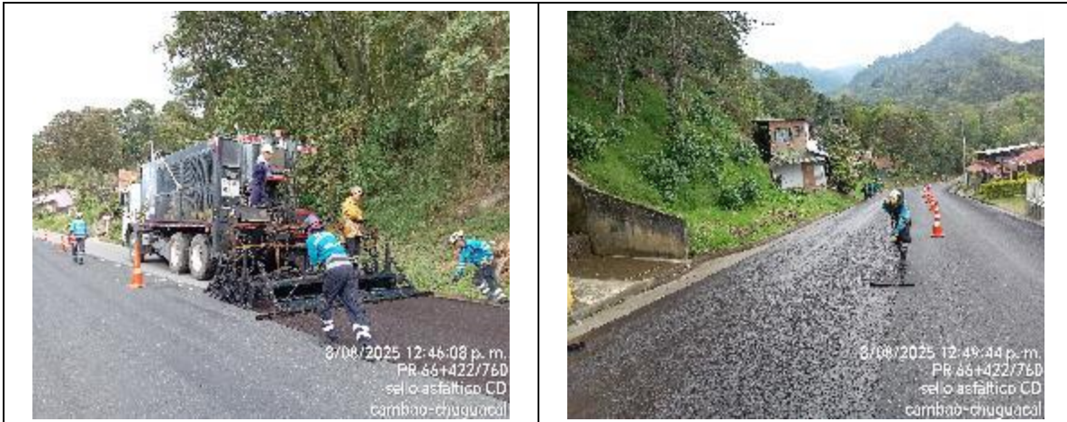
PR66+422 al PR66+760 Instalación de Slurry seal– costado derecho
