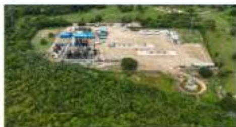
Plataforma Rumba (Facilidades de Producción Rumba)
