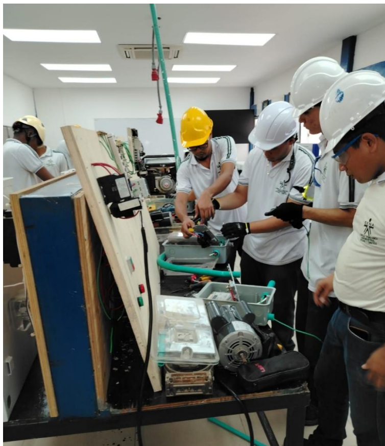
PRACTICA EN MONTAJE Y CONEXIONADO DE MEDIDORES
