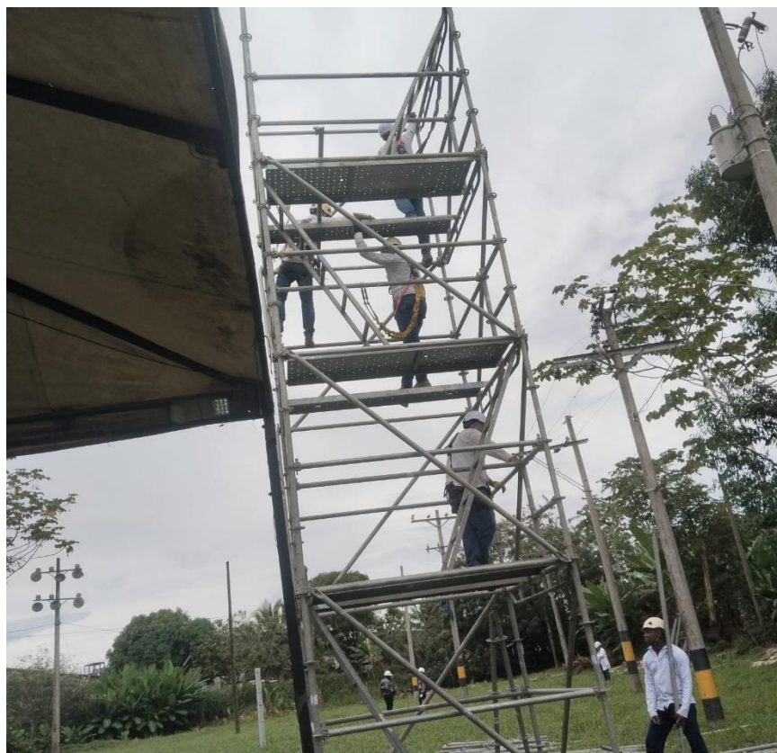
PRACTICA MONTAJE DE ANDAMIOS EN PATIO DE REDES
