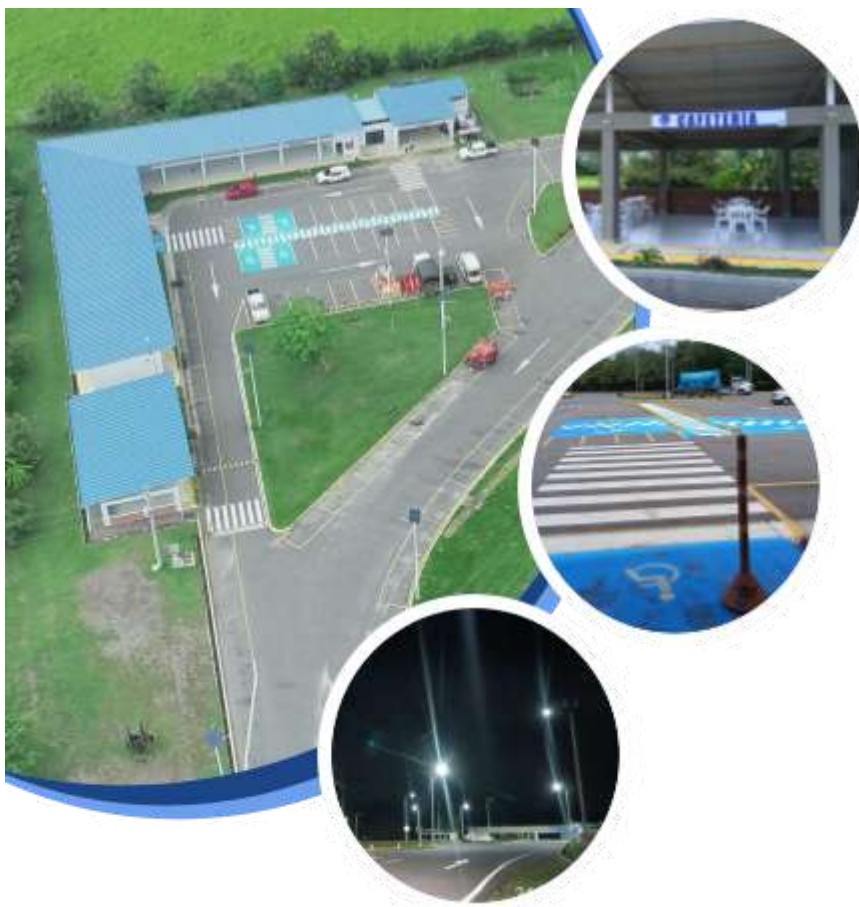
Figura 25. Hallazgos evidenciados Área de Servicios Guarinocito
