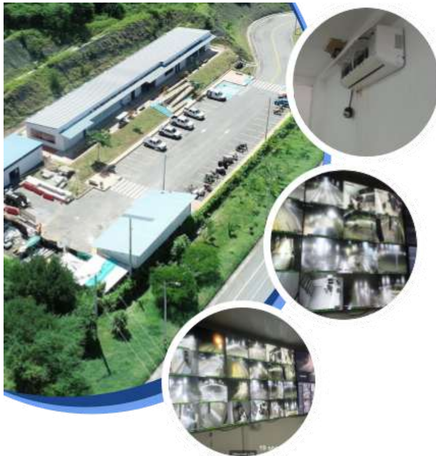
Figura 23. Hallazgos evidenciados en el Centro de Control Operativo.
