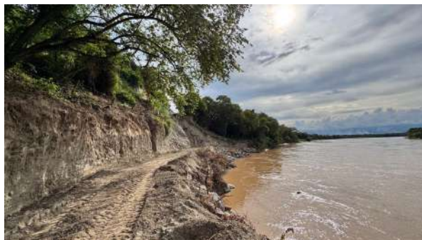
UF3 - PR 66+700 - Avances construcción jarillón (enrocado)
