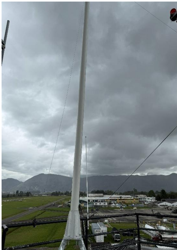
Foto No. 1. Antena instalada
