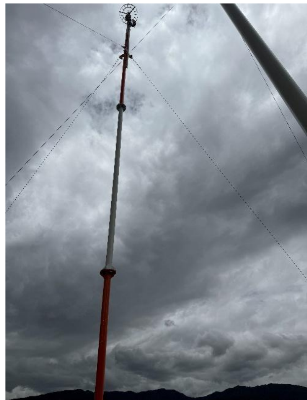
Foto No. 2. Cambio de mástil de pararrayos
