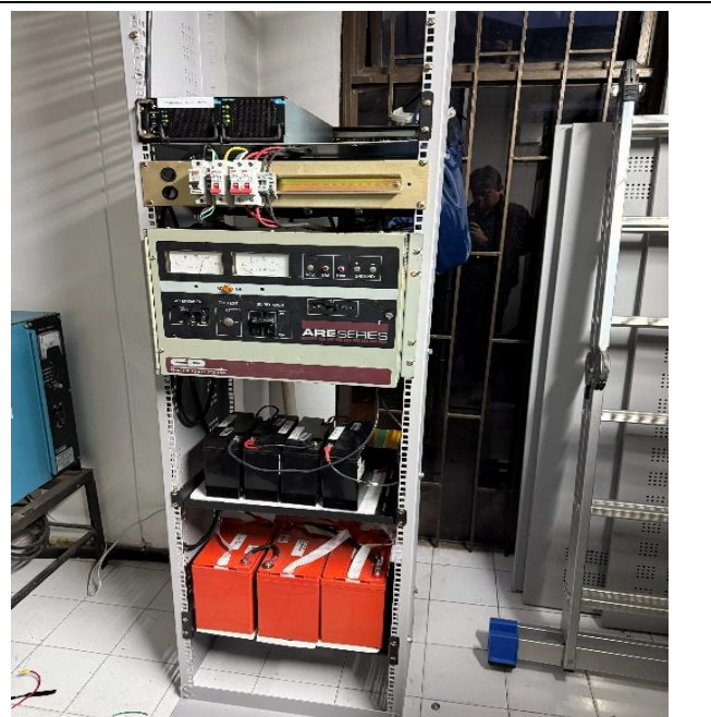
Foto 8. Equipos de energía reubicados en cuarto eléctrico del primer piso
