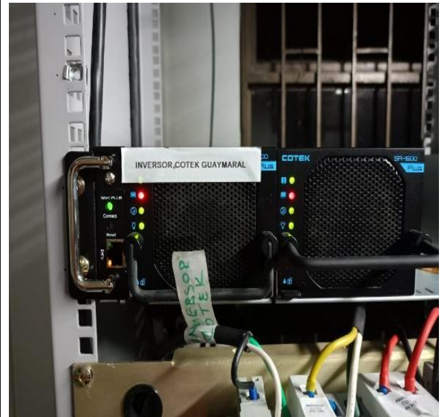
Foto 4. reubicación del sistema de inversor red ATN
