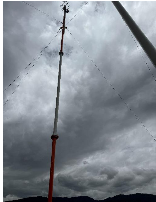
Foto No. 2. Cambio de mástil de pararrayos
