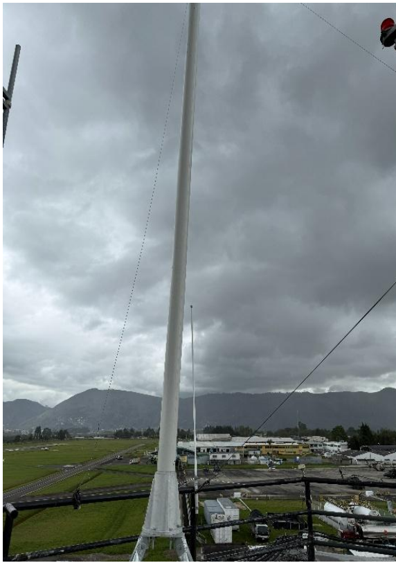
Foto No. 1. Antena instalada
