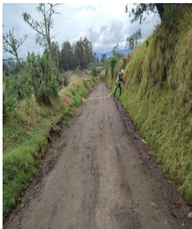
Fotografía No 3 : conducción #1 Se muestra señalización de Zona de trabajo para prevenir dificultades en la zona mientras no se labora
