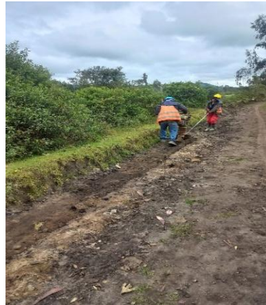
Fotografía No 4 : conducción #1 Se muestra zona de adecuación para transpirabilidad de habitantes
