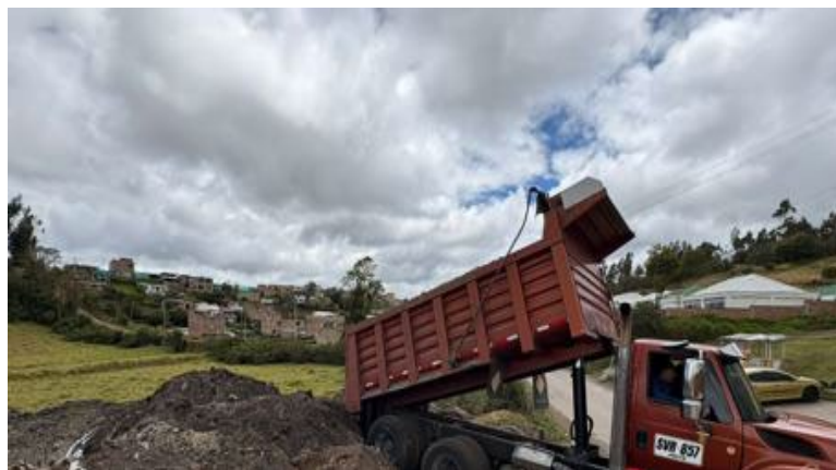
Correcta disposición de material proveniente de excavación
