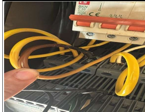
CONEXIONES EN CORTO
