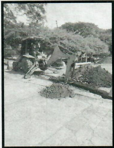
Excavación a máquina
