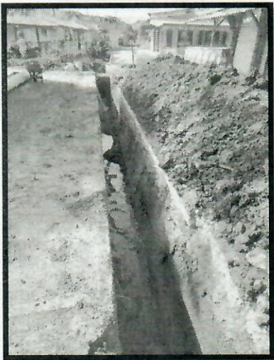
Excavación de tierra a mano
