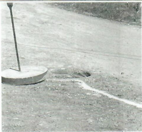
Localización y replanteo
