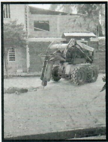
Demolición de pavimento
