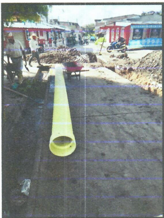
Ubicación de tubería de la red principal
