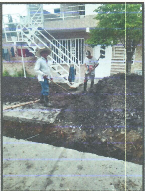
Excavación de tierra a mano y ubicación de tubería de acometidas
