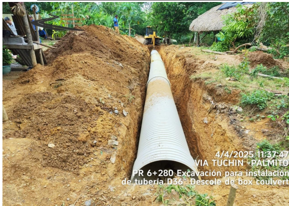
INSTALACIÓN DE TUBERÍA 36"
