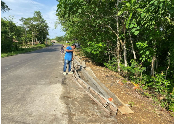
CONSTRUCCIÓN DE BORDILLOS
