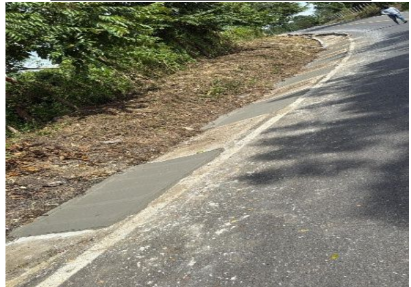
CONSTRUCCIÓN DE CUNETAS
