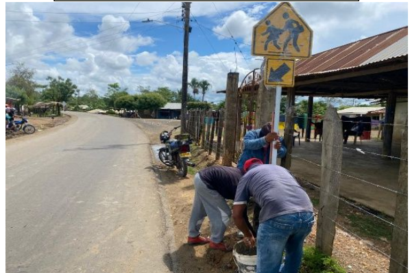
INSTALACIÓN SEÑALES VERTICALES
