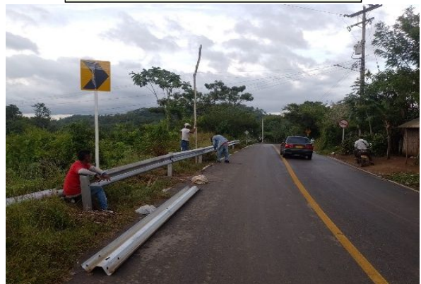
INSTALACIÓN DE DEFENSAR METÁLICAS
