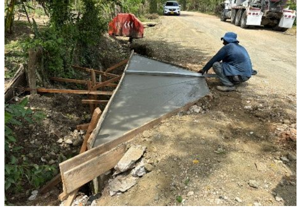
AMPLIACIÓN BOX CULVERT
