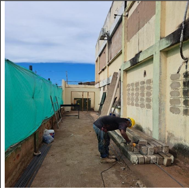
DESMONTE DE PERGOLAS
