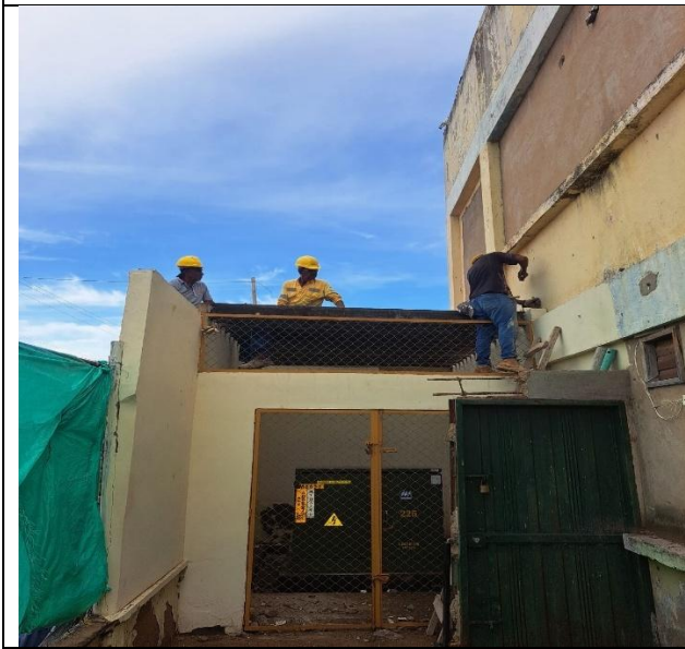
DESMONTE DE PERGOLAS
