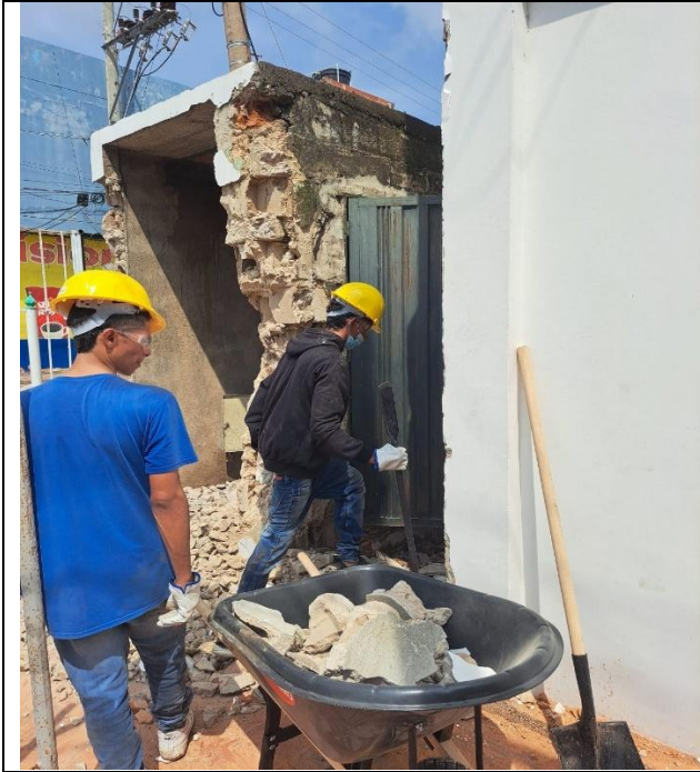
DEMOLICION MUROS Y COLUMNAS
