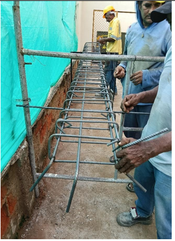
ACERO DE REFUERZO COLUMNAS
