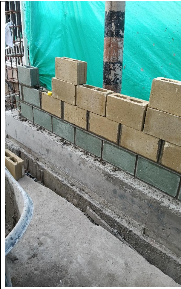
VIGA CIMENTACION Y LEVANTE MURO ABUJARDADO
