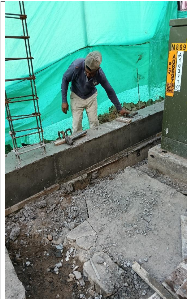
VIGA CIMENTACION Y LEVANTE MURO ABUJARDADO
