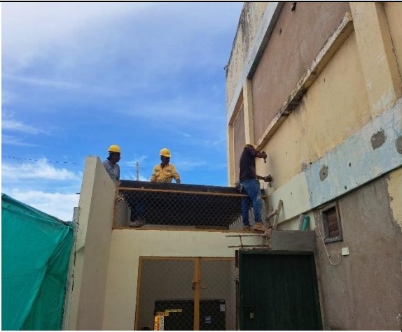
DESMONTE DE PERGOLAS
