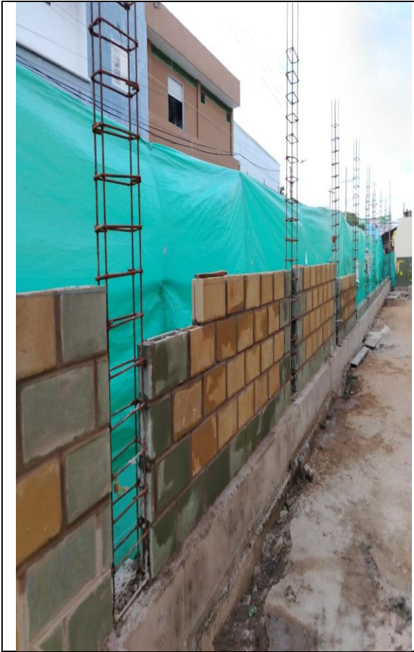
LEVANTE DE MURO ABUJARDADO
