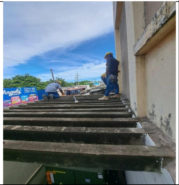
DESMONTE DE PERGOLAS
