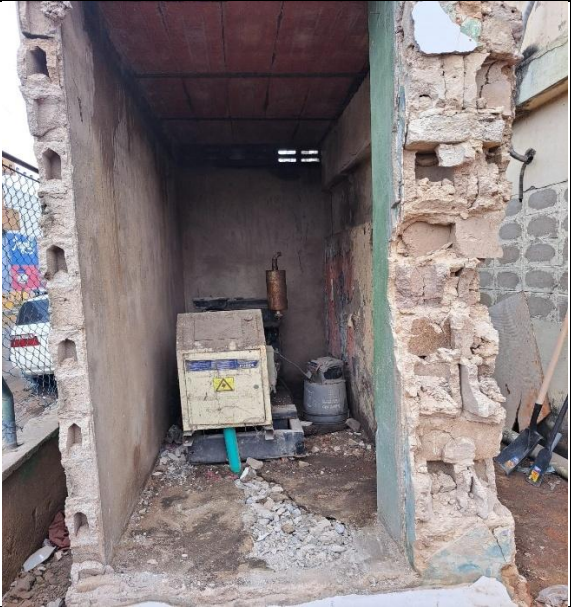
DEMOLICION MUROS Y COLUMNAS
