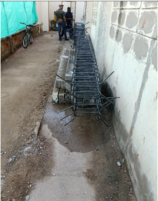
ACERO DE REFUERZO COLUMNAS
