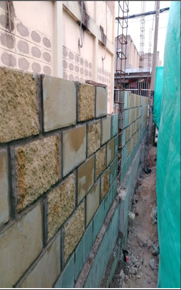
LEVANTE DE MURO ABUJARDADO
