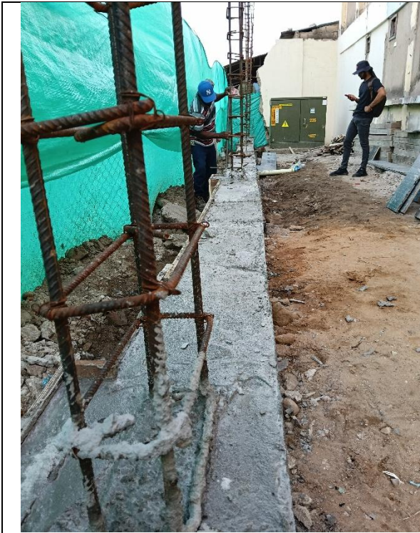
VIGA CIMIENTO CICLOPEO
