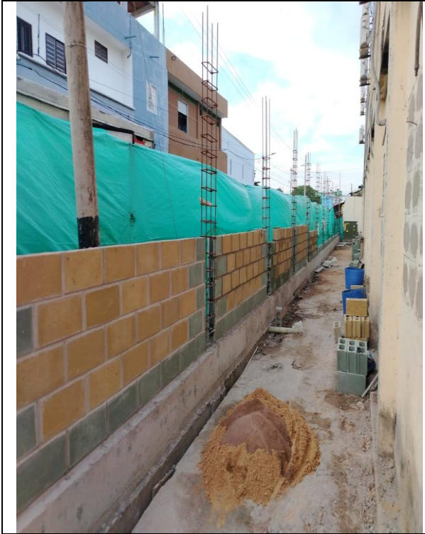
LEVANTE DE MURO ABUJARDADO
