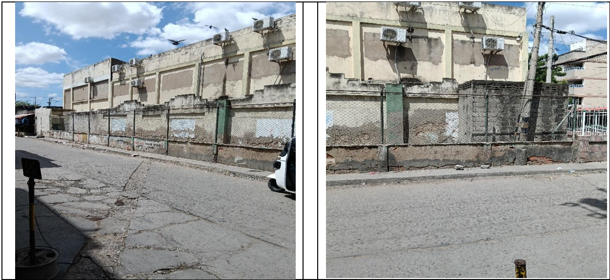
MURO ACTUAL CARRERA 16
