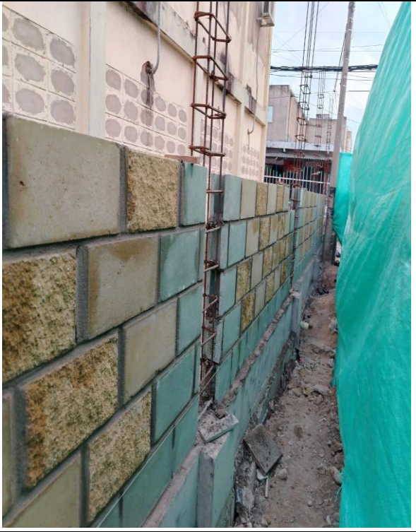
LEVANTE DE MURO ABUJARDADO
