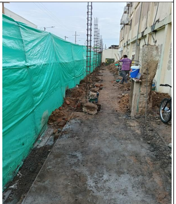
LEVANTE ACERO DE REFUERZO COLUMNAS
