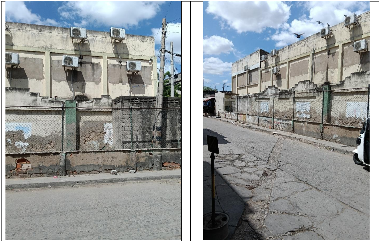
MURO ACTUAL CARRERA 16
