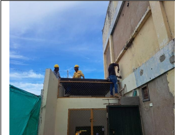
DESMONTE DE PERGOLAS
