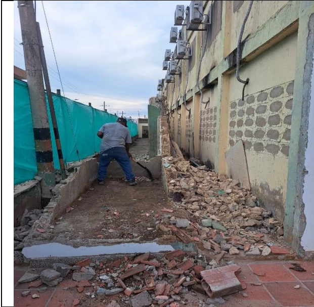
DEMOLICION MUROS Y COLUMNAS
