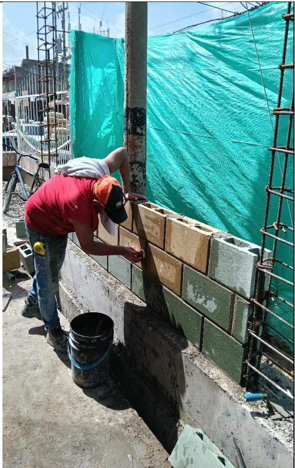
LEVANTE DE MURO ABUJARDADO
