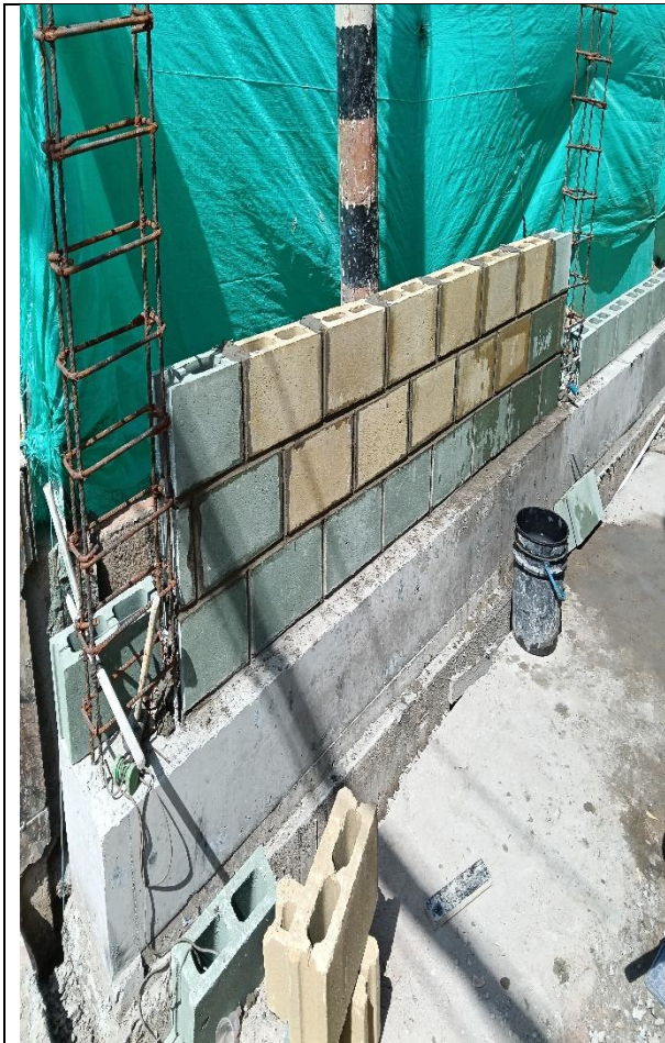
LEVANTE DE MURO ABUJARDADO
