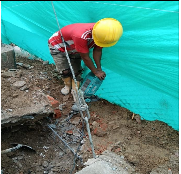
DEMOLICION DE VIGA CUMIENTO
