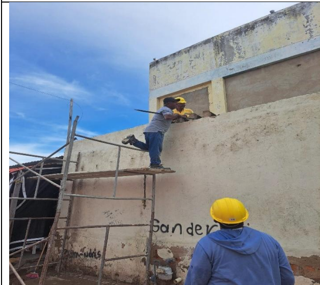
DESMONTE DE PERGOLAS
