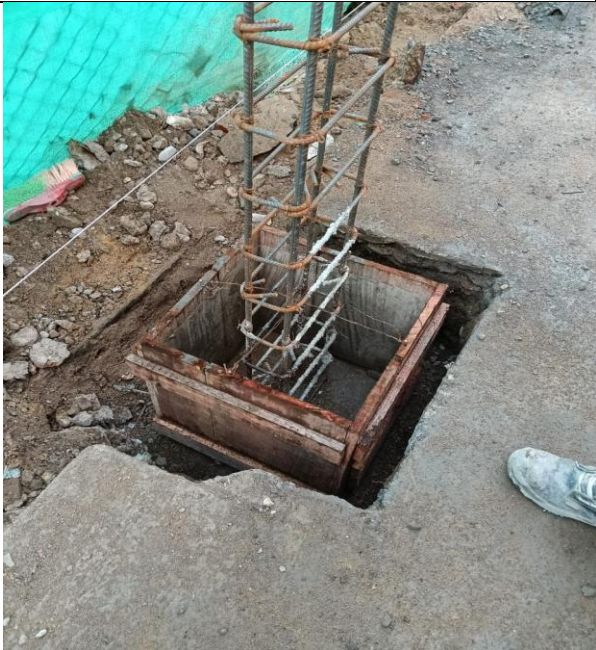
COLUMNA Y ZAPATA PEDESTAL
