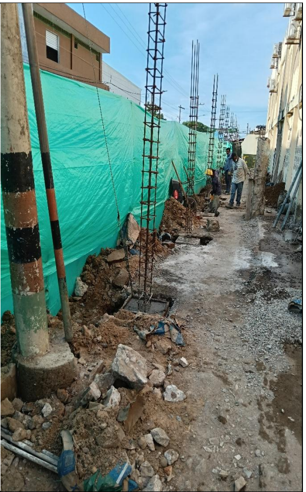
EXCAVACIONES DE ZAPATAS
