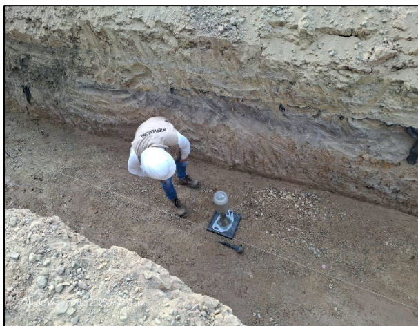
FOTOGRAFIA No. 7. Inspección y control de ensayos de laboratorios de toma de densidades en campo.
