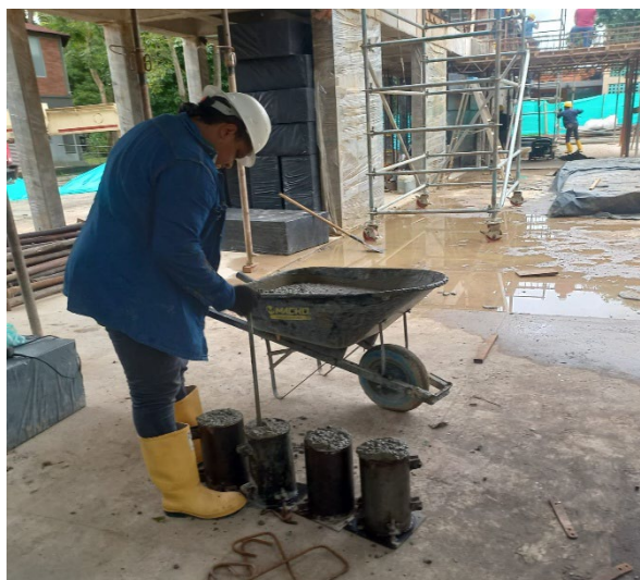
FOTOGRAFIA No. 34. Elaboración de Ensayos de cilindros en concreto de 3500 PSI en campo.
