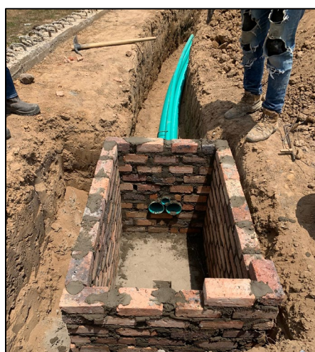
FOTOGRAFIA No. 23. Inspección de ducto subterráneo tubería PVC 2 pulg. (incluye suministro, transporte e instalación).
