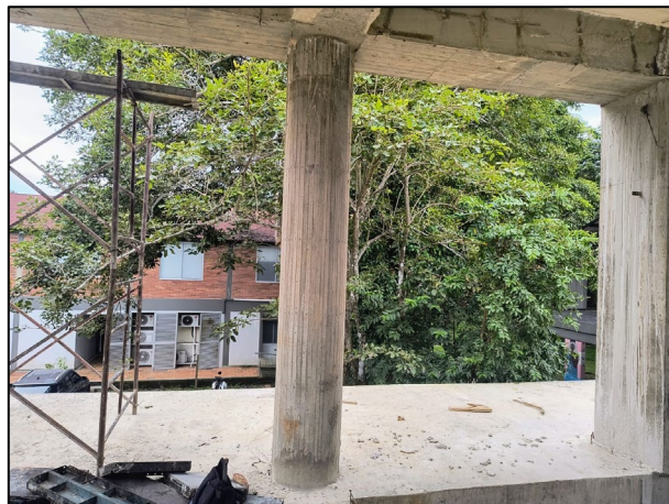
FOTOGRAFIA No. 4. Inspección de columna circular ø:50 cm fundida en concreto de 3500 PSI.
