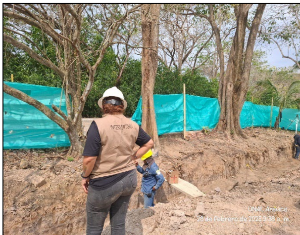
FOTOGRAFIA No. 10. Verificación de excavación de vigas de cimentación en concreto de 3500 PSI E=0.25 M.
