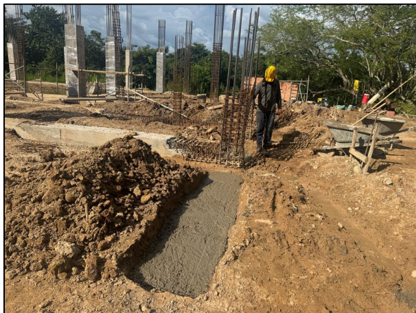
FOTOGRAFIA No. 25. Verificación de Fundida de concreto de limpieza e=0.05 m.(solado).
