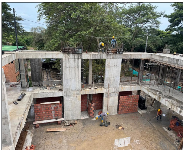
FOTOGRAFIA No. 9. Verificación de la Construcción de muro en concreto de 3500 PSI E=0.25 M.
