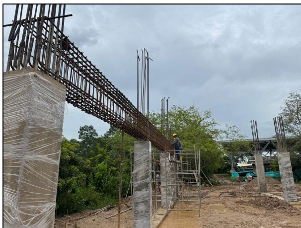
FOTOGRAFIA No. 31. Inspección y control en armado de Acero de refuerzo (incluye corte y figurado).
