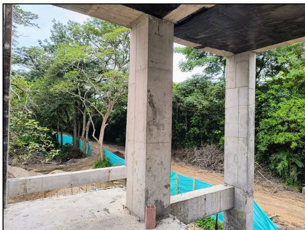
FOTOGRAFIA No. 5. Verificación de columnas de 0.50 x 0.65 M., fundidas en concreto 3500 PSI.
