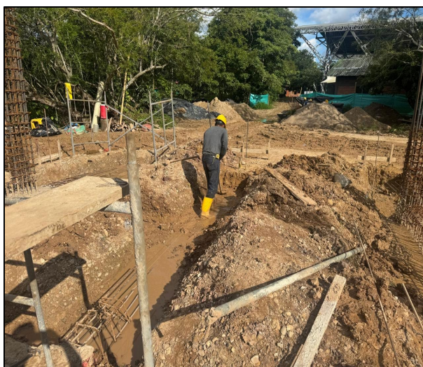
FOTOGRAFIA No. 24. Verificación de Trabajos de excavación manual en material común entre 0-2 m. de profundidad.
