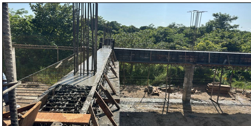
FOTOGRAFIA No. 29. Inspección de fundida de Viga aérea en concreto de 3500 PSI 0.50x0.70 m para placa de entrepiso nivel=3.46 m.
