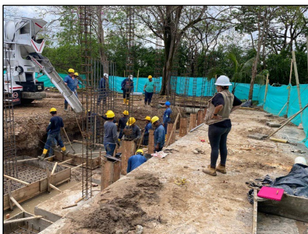
FOTOGRAFIA No. 14. Inspección de fundida de Zapata en concreto de 3500 PSI.
