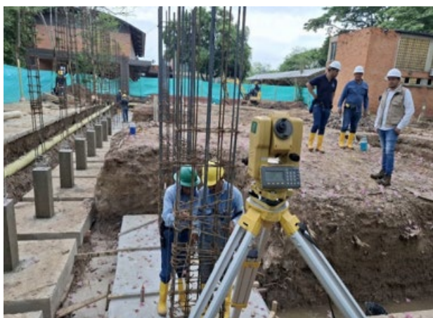
FOTOGRAFIA No. 17. Inspección de armado de Acero en Columnas de 3500 PSI.
