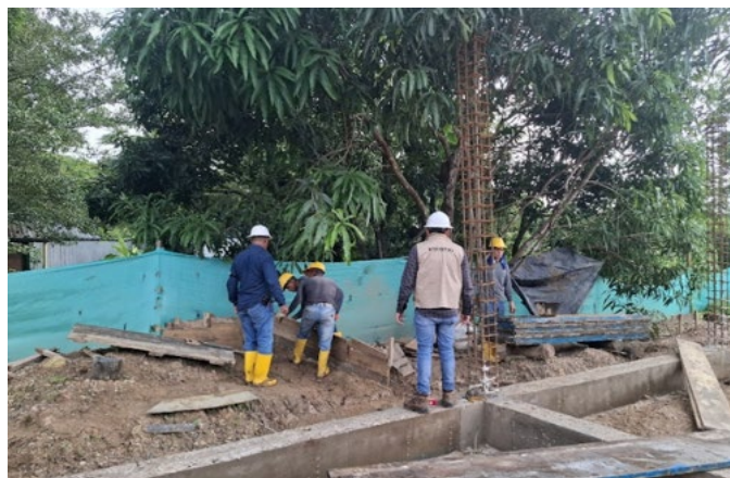
FOTOGRAFIA No. 22. Control de actividades de instalación de formaleta para columna en concreto de 3500 PSI.
