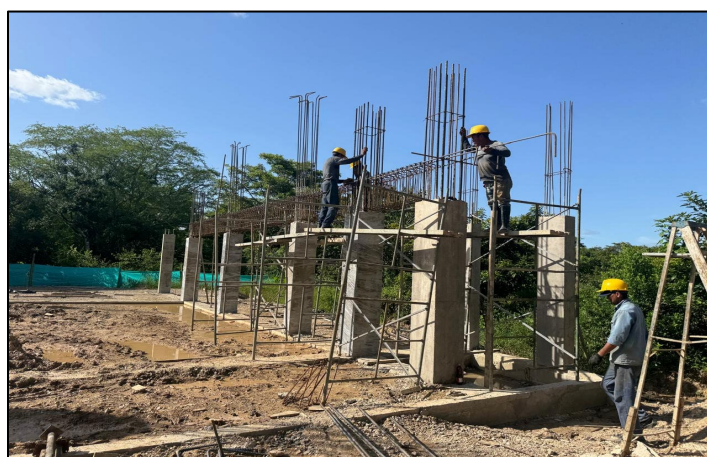
FOTOGRAFIA No. 30. Verificación de armado de acero en Columna en concreto de 3500 PSI sección 0.16x0.50 m., 0.25x0.50 m., 0.30x0.30 m., 0.50x0.50 M.
