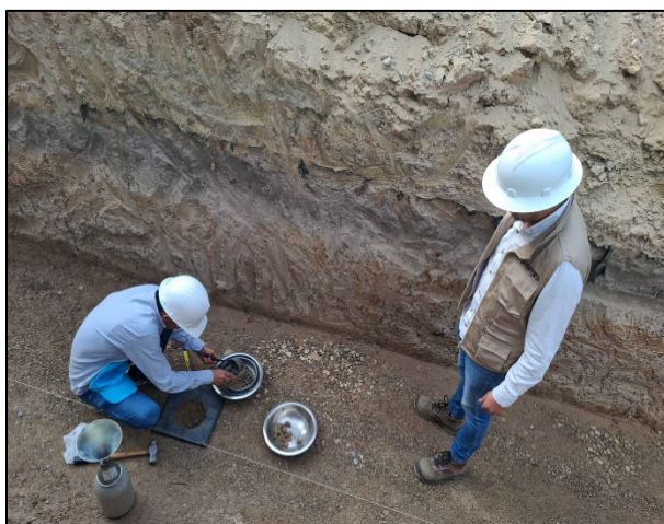
FOTOGRAFIA No. 32. Inspección de laboratorios de toma de densidades en material granular.
