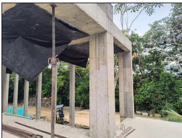
FOTOGRAFIA No. 6. Verificación de columnas de 0.50 x 0.65 M., fundidas en concreto 3500 PSI.
