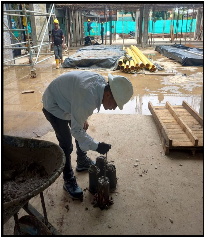
FOTOGRAFIA No.3 Y No.4 TOMA DE MUESTRA DE CILINDROS EN CONCRETO.
