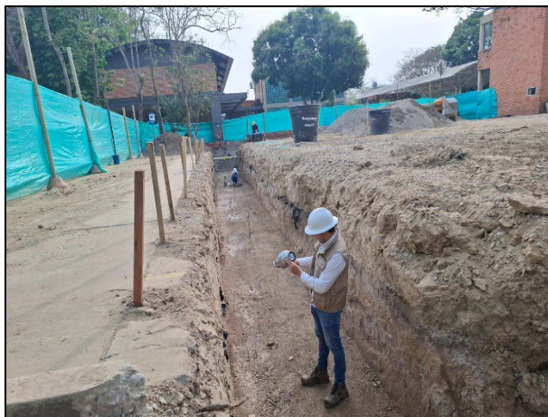
FOTOGRAFIA No. 33. Control de ensayos laboratorios densidades en material granular.
