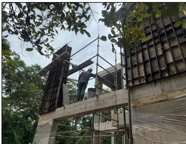
FOTOGRAFIA No. 8. Inspección de la construcción de muro en concreto de 3500 PSI E=0.25 M.
