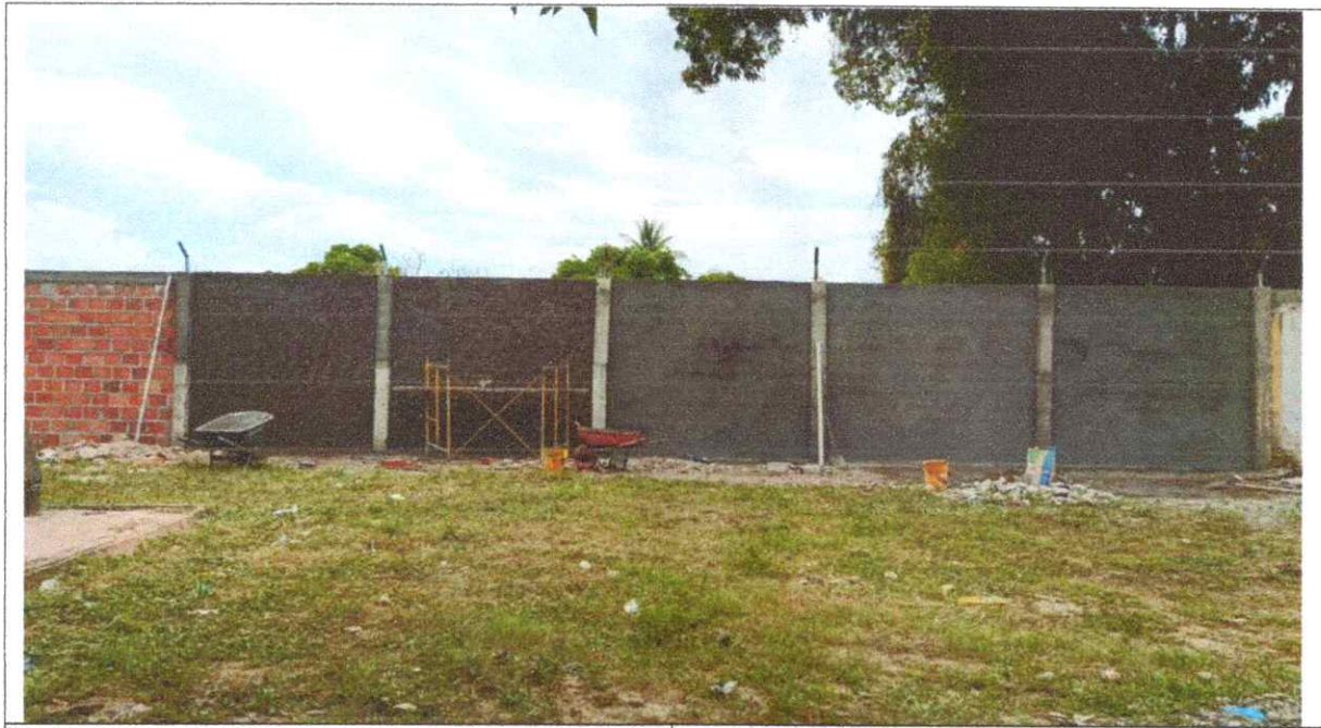
3.1. COLUMNA EN CONCRETO DE 20.7 MPa 0.25x0.25 m
