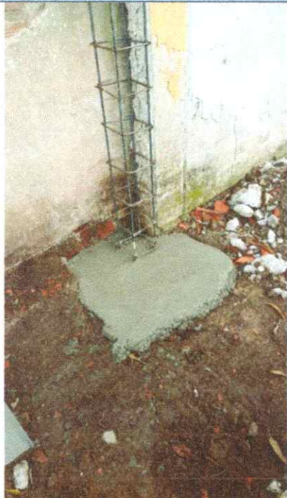
2.1. ZAPATA EN CONCRETO DE 20.7 Mpa
