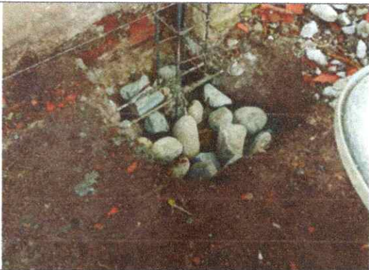
2.3. CONCRETO CICLOPEO (60% CONCRETO 20.7Mpa 40% PIEDRA)
