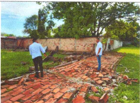
1.2. DEMOLICIÓN DE COLUMNAS E CONCRETO
