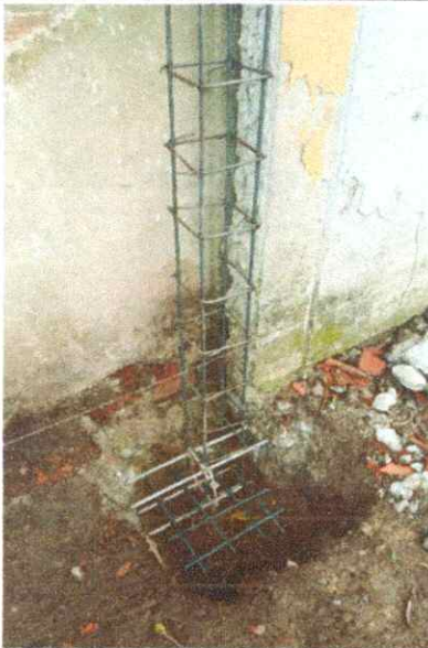
1.3. EXCAVACIÓN MANUAL CIMENTACION
