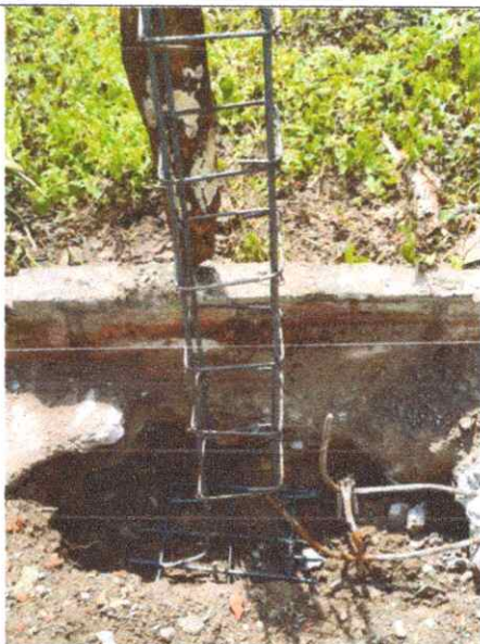
2.5. ACERO DE REFUERZO DE F_y = 420 MPa
