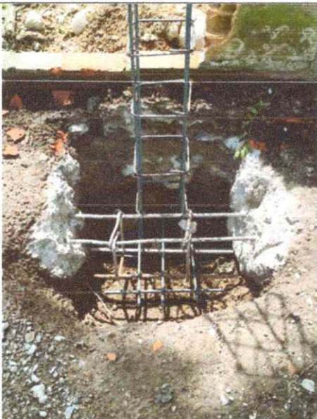
2.5. ACERO DE REFUERZO DE F_y = 420 MPa
