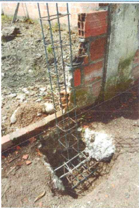
2.2. PEDESTAL EN CONCRETO DE 20.7 Mpa
