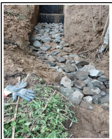
Fecha: Octubre 2025 Descripción: Filtro en piedra y geotextil en canal.
