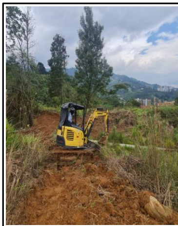
Fecha: Octubre 2025 Descripción: Excavación mecánica y manual para conformación de canales nuevos en terreno natural para desalojo de aguas empozadas en zonas donde se presentan hundimientos y demás aguas que se encuentren.
