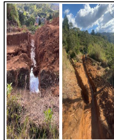
Fecha: Octubre 2025 Descripción: Excavación mecánica y manual para conformación de canales nuevos en terreno natural para desalojo de aguas empozadas en zonas donde se presentan hundimientos y demás aguas que se encuentren.
