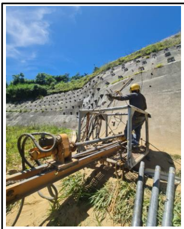
Fecha: Octubre 2025 Descripción: Drenes horizontales en muro pantalla.
