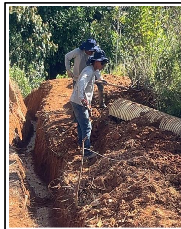
Fecha: Octubre 2025 Descripción: Excavación mecánica y manual para conformación de canales nuevos en terreno natural para desalojo de aguas empozadas en zonas donde se presentan hundimientos y demás aguas que se encuentren.
