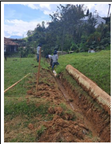
Fecha: Octubre 2025 Descripción: Retiro de medios tubos (cunetas).
