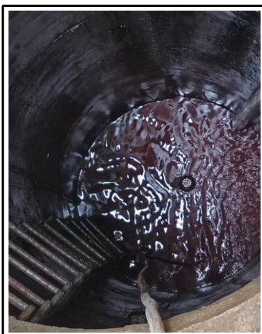
Fecha: Octubre 2025 Descripción: Aplicación de anilina en pilas drenantes.
