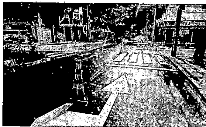
DESCRIPCIÓN. Demarcación de flechas de sentido vial con pintura plastico en frío - Sector Camino Verde.
