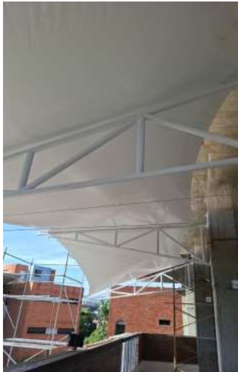
Imagen 1. Instalación de la carpa
