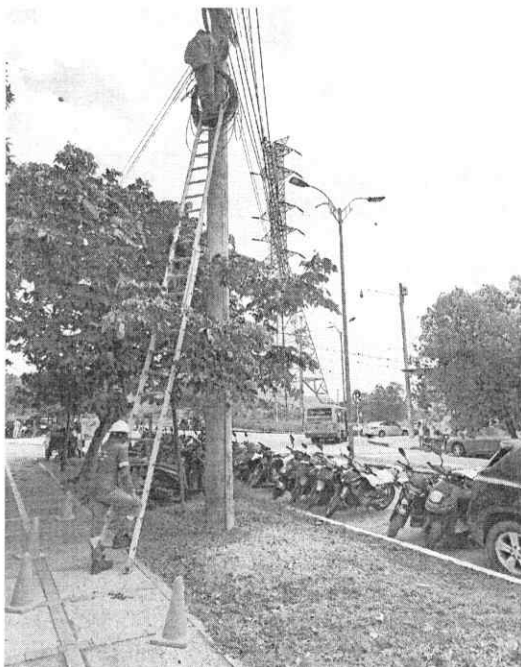
Ilustración 1 Instalación de fibra óptica en poste exterior 1
