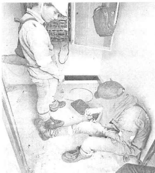
Ilustración 6 Instalación del enlace en la sede EQUION
