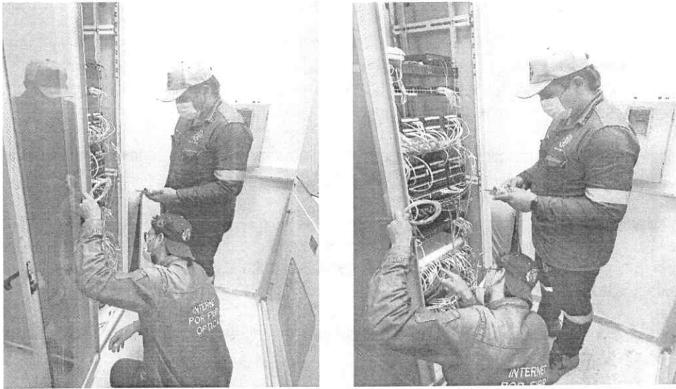
Ilustración 16 Mantenimiento preventivo al enlace de fibra óptica y medición de potencia de la señal
