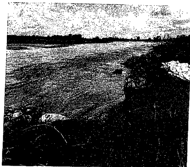
Imagen 1. Afectación a gaviones
