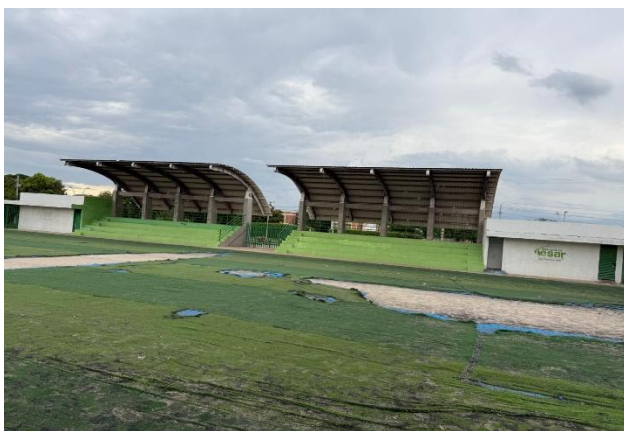
Imágenes del mal estado de la grama sintética de la cancha del parque mareigua-paramo
