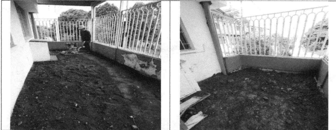
Instalacion de cerramiento
