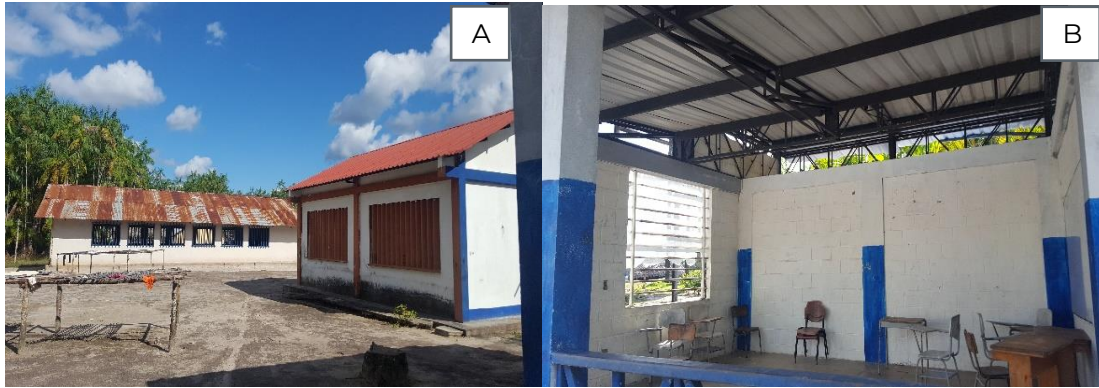
Figura 17. Institución educativa Catanacuname: a) Infraestructura exterior; b) Salón de clases 1° a 5°.
