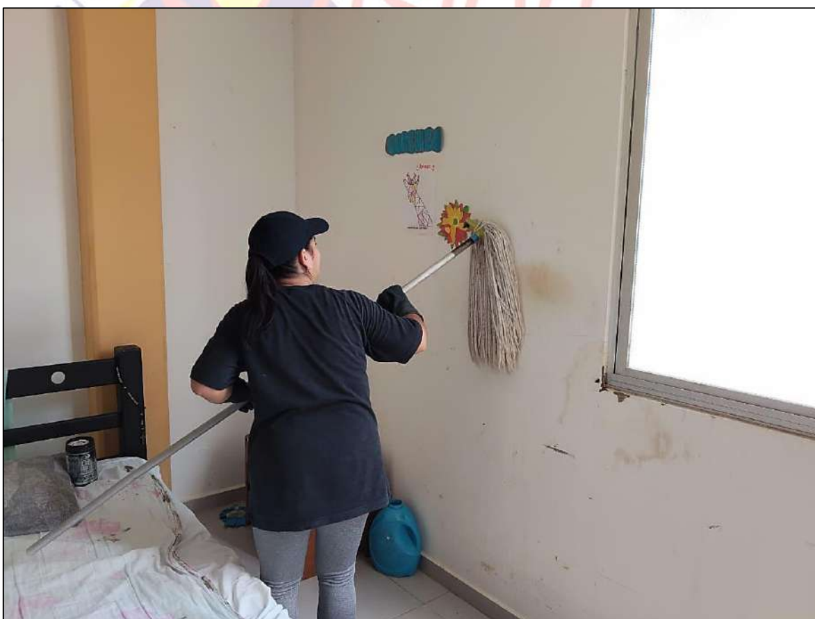
Imagen 6. Limpieza y desinfección de paredes en la infraestructura de la institución HOGAMI.
