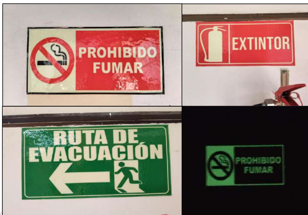
Imagen 118, 119, 120 y 121. Instalación de nueva señalización (reflectiva).
