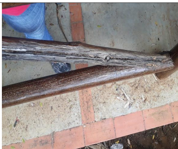
Se evidencio deterioro y falta de mantenimiento en los pasamanos del kiosco
