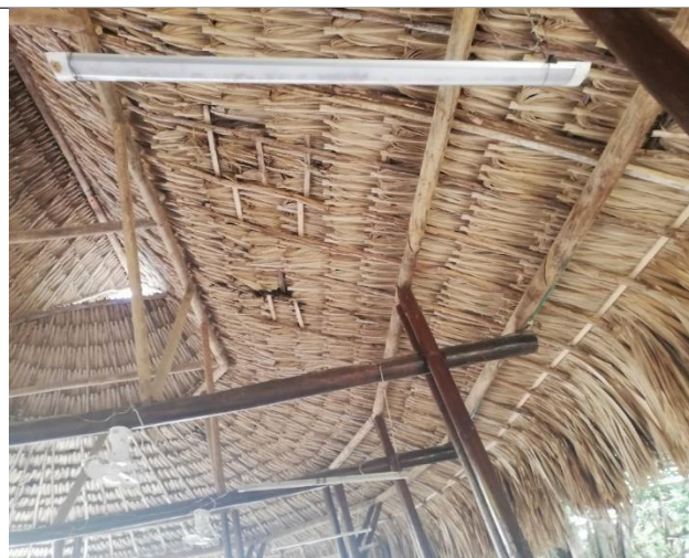
Se observó deterioro en la cubierta de palma amarga del kiosco en varias partes
