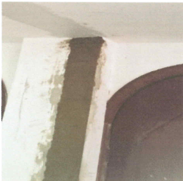
Figura 25: Pañete Sobre Muro Después de la Demolición.
