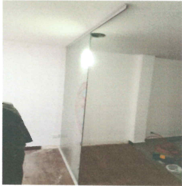
Figura 19: Montaje de Vidrio Templado 8 mm Divisorio de Personería Municipal.
