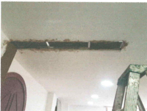
Figura 35: Sección de Techo Después de la Demolición de Muro.
