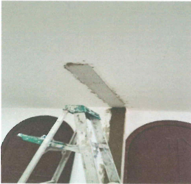
Figura 37: Sección de Techo en Drywall.
