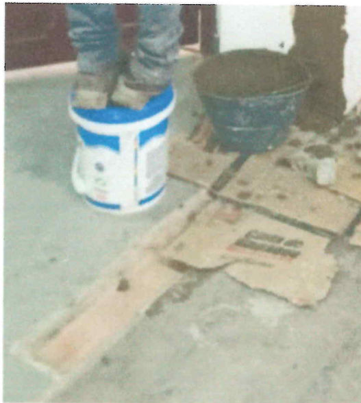
Figura 20: Estado de Piso Después de Demolición de Muro.
