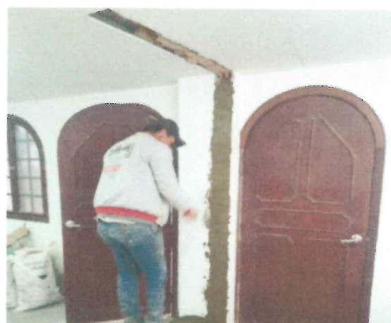
Figura 36: Sección de Techo Después de la Demolición de Muro.
