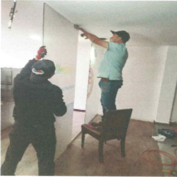
Figura 18: Montaje de Vidrio Templado 8 mm Divisorio de Personería Municipal.
