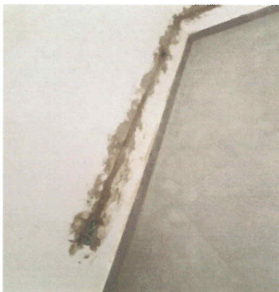
Figura 26: Pañete Para Regatas de Toma Dobles.
