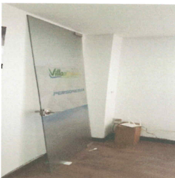
Figura 17: Desmonte Vidrio Templado 8 mm Divisorio de Personería Municipal.
