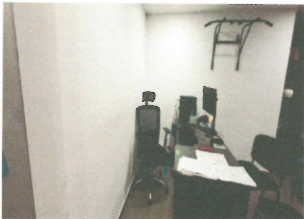
Figura 31: Muros Personería Municipal.
