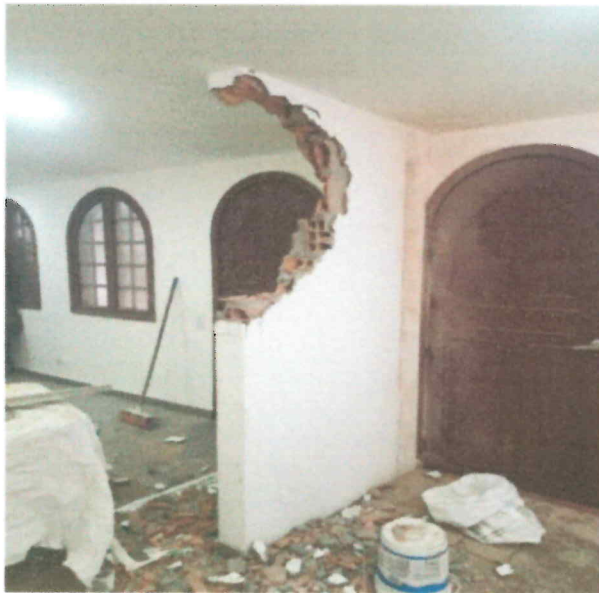
Figura 3: Demolición de Muro Divisorio.
