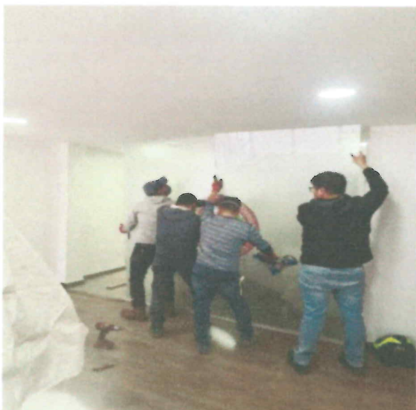
Figura 16: Desmonte Vidrio Templado 8 mm Divisorio de Personería Municipal.
