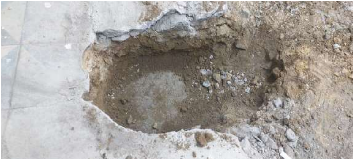
Demolición enchape/piso Secretaria de Hacienda.
