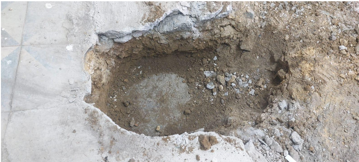
Demolición enchape/piso Secretaria de Hacienda.
