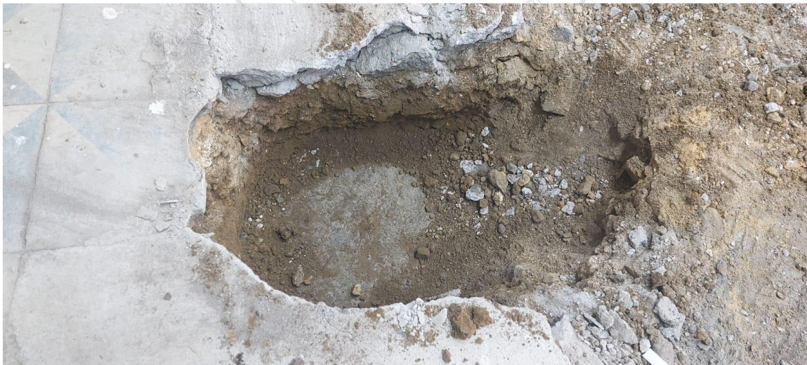
Demolición enchape/piso Secretaria de Hacienda.
