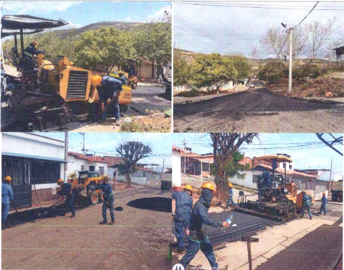
3,20 SUMINISTRO E INSTALACIÓN DE MEZCLA ASFÁLTICA MDC-19 PARA BACHEO: 208,30 M3
