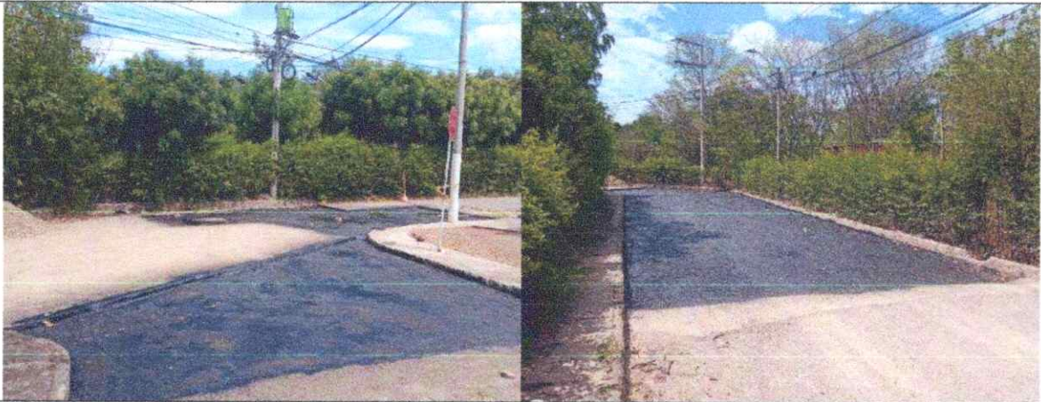
3,20 SUMINISTRO E INSTALACIÓN DE MEZCLA ASFÁLTICA MDC-19 PARA BACHEO: 208,30 M3
