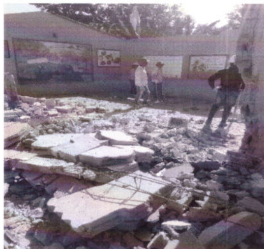
Fotografía 10 Demolición muros San Juansito
