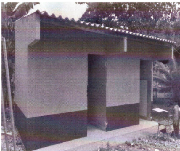
Fotografía 9 Adecuación de baños San juansito
