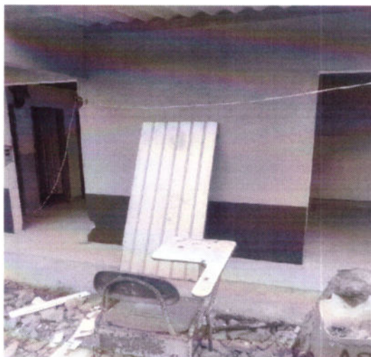
Fotografía 2 Demolición muros SAN JUANSITO
