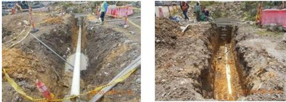
Figura 4 Mantenimiento Tunel Liner / Fuente: Informe Final Contrato de Interventoría N° 17000995 H3 DE 2017 31/01/2019
