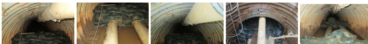
Figura 5 Actividades al interior Tunnel Linner / Fuente: Informe Final Contrato de Interventoría N° 17000995 H3 DE 2017 31/01/2019
