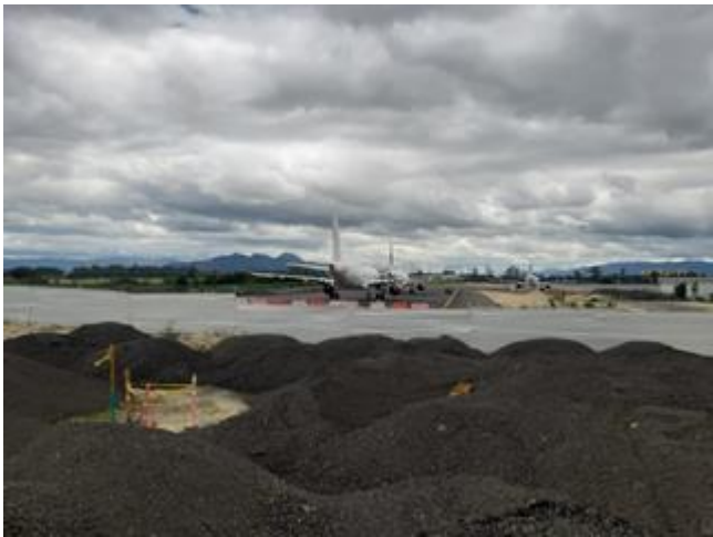
Figura 17 Material de Fresado en Zona 3 de Calle Lima / Fuente: Aerocivil Julio de 2020
