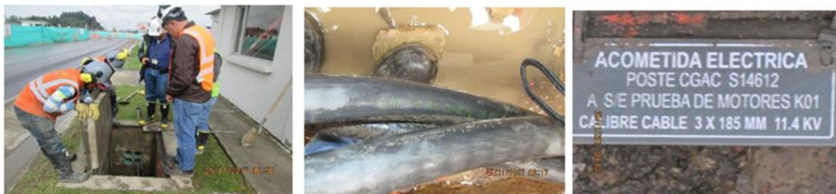
Figura 8 Actividades traslado redes secas / Fuente: Informe Final Contrato de Interventoría N° 17000995 H3 DE 2017 31/01/2019
