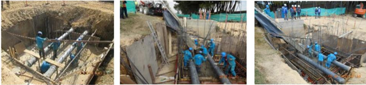
Figura 6 Actividades cámara Bypass / Fuente: Informe Final Contrato de Interventoría N° 17000995 H3 DE 2017 31/01/2019
