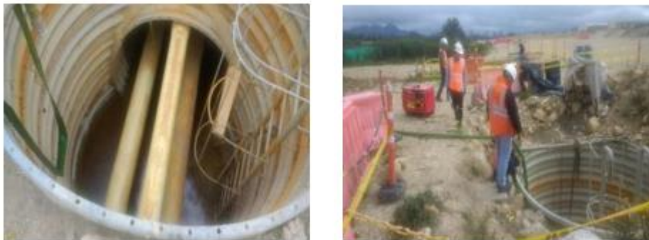
Figura 3 Mantenimiento Tunel Liner / Fuente: Informe Final Contrato de Interventoría N° 17000995 H3 DE 2017 31/01/2019
