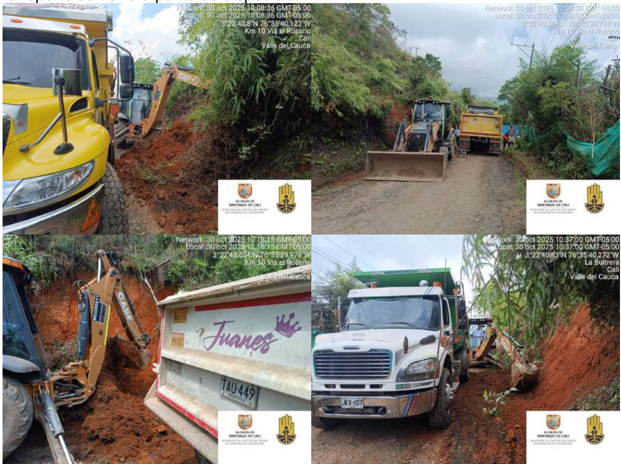
Fotografías 27,28,29 y 30. Evidencia de ejecución de labores en el sector Km 12 Vía La Buitrera el día 30 de octubre de 2025
