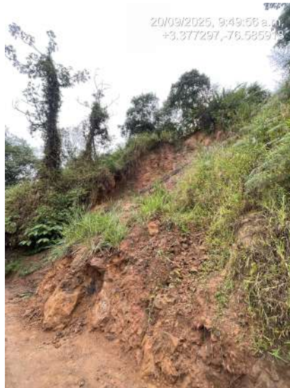
Fotografía 1. Punto en la carbonera antes de la intervención.
