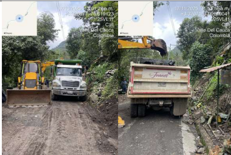
Fotografía 49 y 50. Evidencia de Volquetas prestando servicio el 17 de noviembre de 2025.
