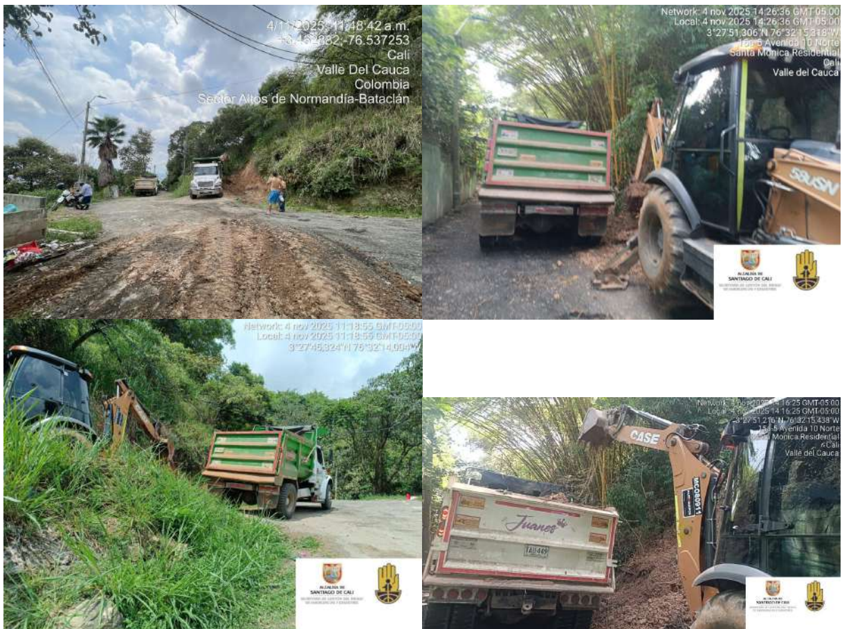
Fotografías 44,45,46 y 47. Evidencia de ejecución de actividades en el sector de Bataclán el 4 de noviembre de 2025.
