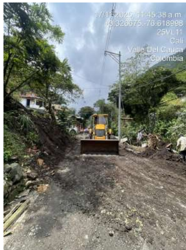
Fotografía 51. Evidencia de retroexcavadora prestando servicio el 17 de noviembre de 2025.
