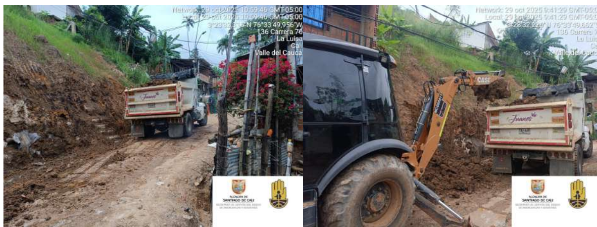
Fotografías 21 y 22. Evidencia de ejecución de labores en el sector Las Veraneras el día 29 de octubre de 2025
