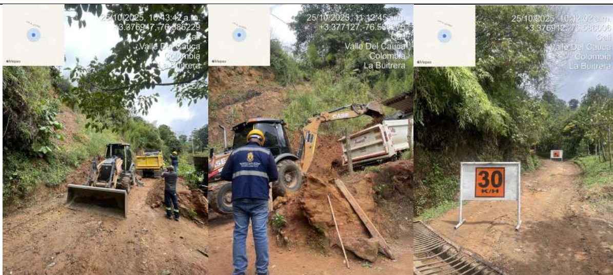
Fotografías 2,3 y 4. Evidencia de equipos ejecutando labores en La Carbonera
