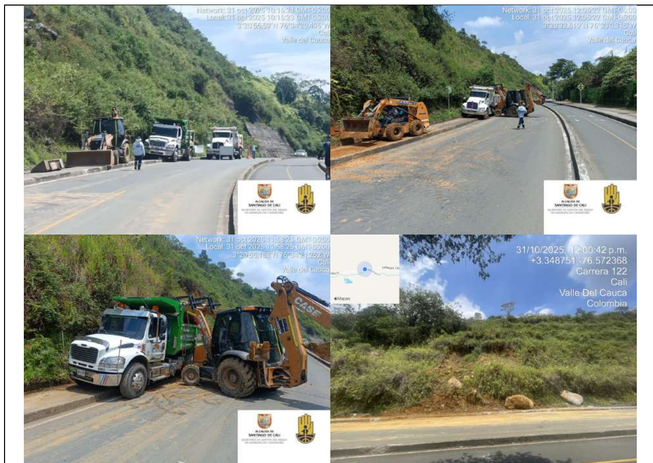
Fotografías 36,37,38 y 39.. Evidencia de ejecución de labores en el sector Pance entrada 3 el día 31 de octubre de 2025
