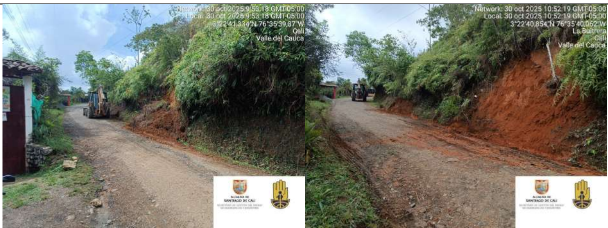
Fotografías 31 y 32. Evidencia de antes y después de la ejecución de labores en el sector Km 12 Vía La Buitrera el día 30 de octubre de 2025
