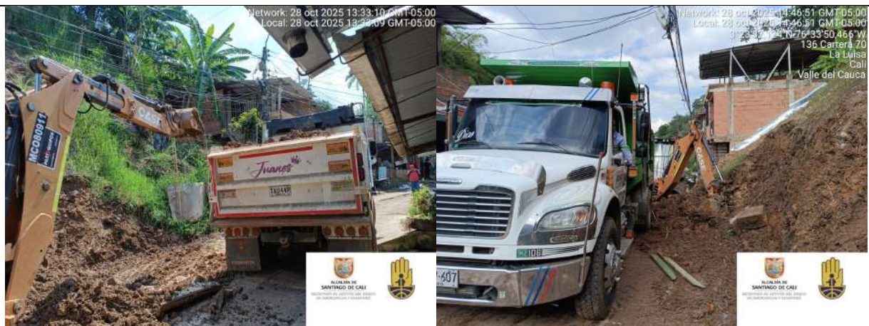
Fotografías 18 y 19. Evidencia de ejecución de labores en el sector Las Veraneras el día 28 de octubre de 2025
