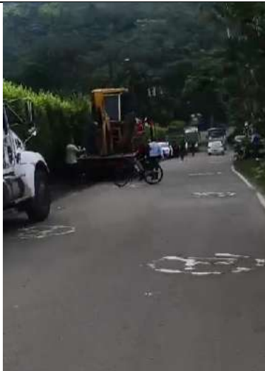
Fotografía 52. Evidencia de servicio de grúa para retroexcavadora el 17 de noviembre de 2025.
