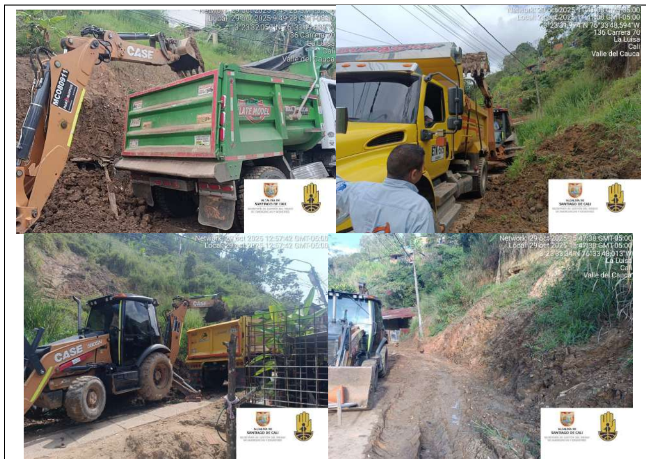
Fotografías 23,24,25 y 26. Evidencia de ejecución de labores en el sector Las Veraneras el día 29 de octubre de 2025
