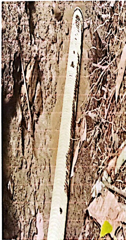
INSTALACION DE TUBERIA CORRUGADA
