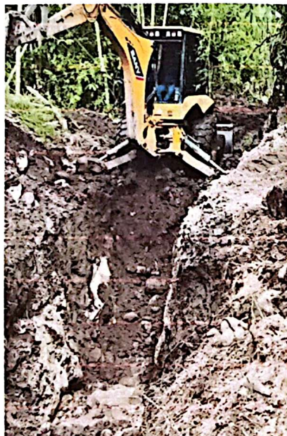
RELLENO CON MATERIAL DE LA MISMA EXCAVACION
