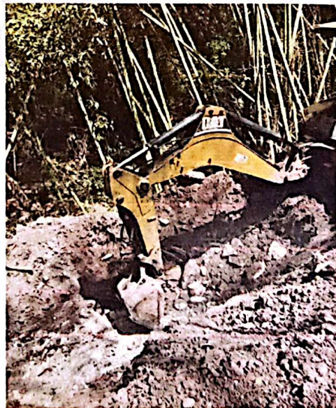
EXCAVACION MECANICA EN ROCA
