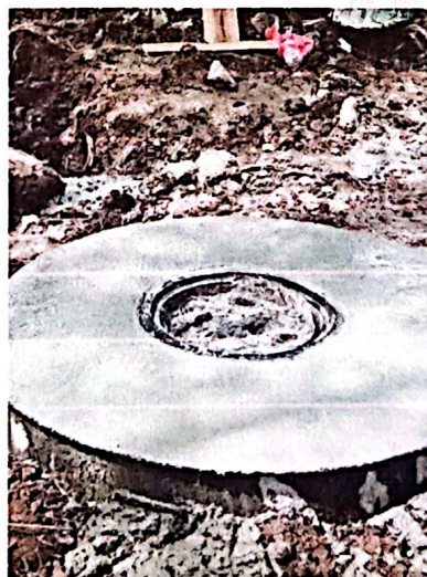
FUNDICIÓN DE POZO DE INSPECCIÓN
