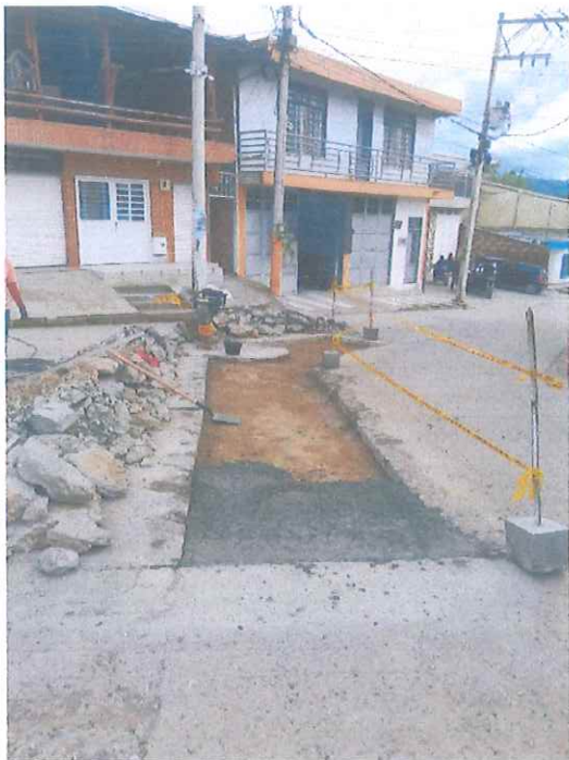
INSTALACIÓN PLACAS DE CONCRETO Y APLICACIÓN ANTISOL
