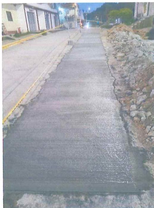
INSTALACIÓN Y VIBRADO DEL CONCRETO DE CONCRETO
