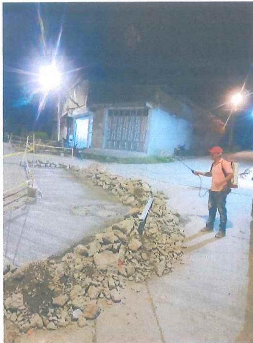
INSTALACIÓN PLACAS DE CONCRETO Y APLICACIÓN ANTISOL
