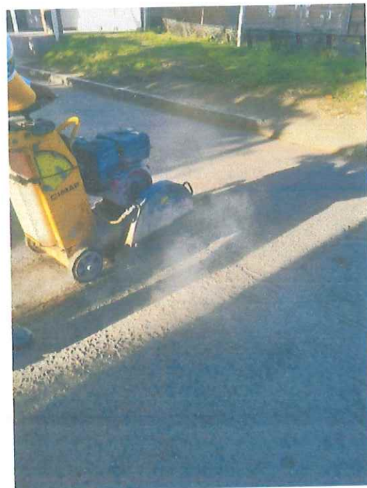
CORTE DE FRONTERA PARA CONCRETO
