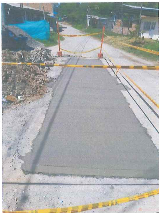
ACABADOS DE LAS PLACAS Y APLICACIÓN DEL ANTISOL
