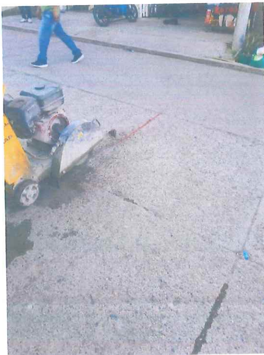
CORTE DE FRONTERA PARA CONCRETO
