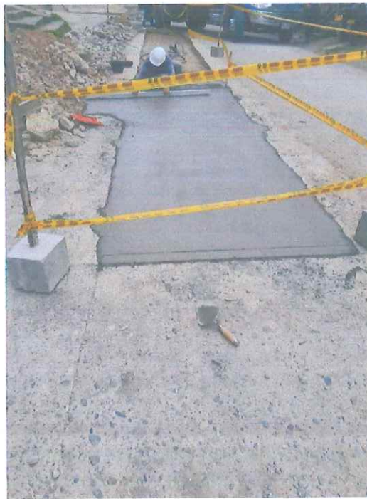
ACABADOS DE LAS PLACAS Y APLICACIÓN DEL ANTISOL
