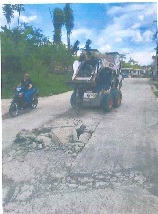
DEMOLICIÓN PLACAS DE CONCRETO
