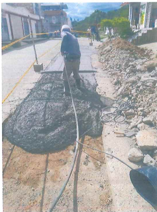
INSTALACIÓN Y VIBRADO DEL CONCRETO DE CONCRETO
